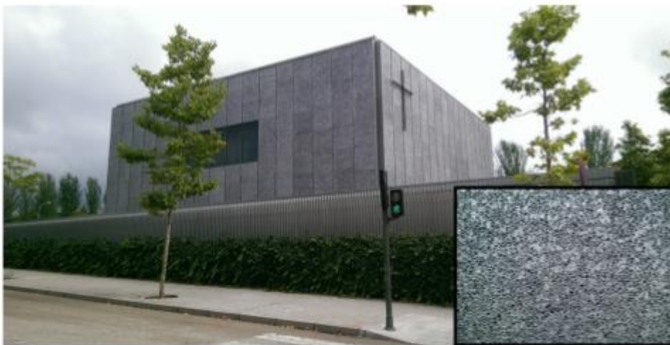
Εικόνα 2.21. Προτεσταντική εκκλησία στην Terrasa, Ισπανία φτιαγμένη από μεταλλικό αφρό Alusion (john Banhart)
