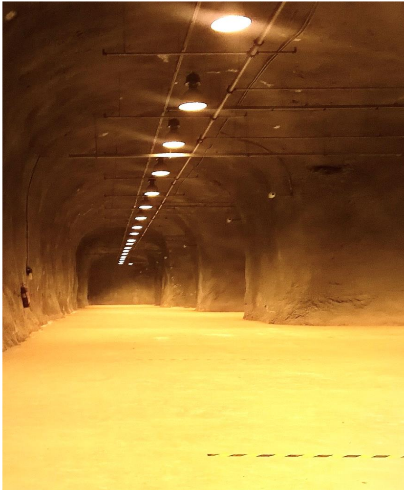
Σχήμα 67: Εσωτερικό υπόγειου χώρου
