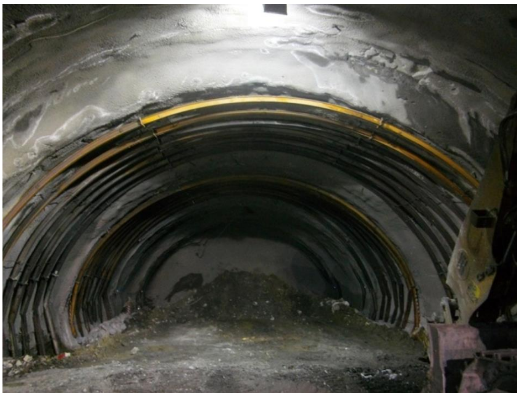
Εικόνα 12: Έδραση σε διευρυμένα πέλματα (Σοφιανός, 2015 από ΟΚ Μελετητική).
