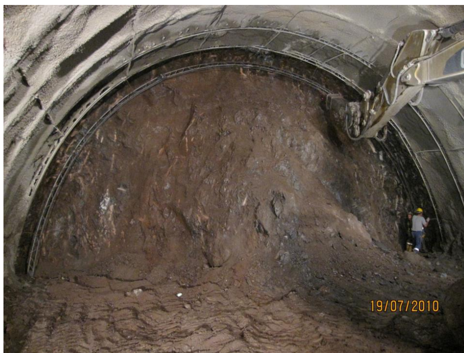
Εικόνα 13: Τοποθέτηση δικτυωτού πλαισίου (Σοφιανός, 2015 από ΟΚ Μελετητική).
