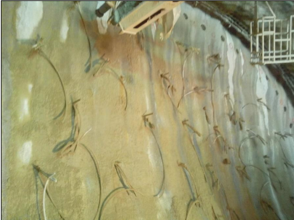
Εικόνα 40 : Μέτωπο εκσκαφής υποστηριγμένο με αγκύρια fiberglass (Πηγή: Γεωργίου Δ.).
