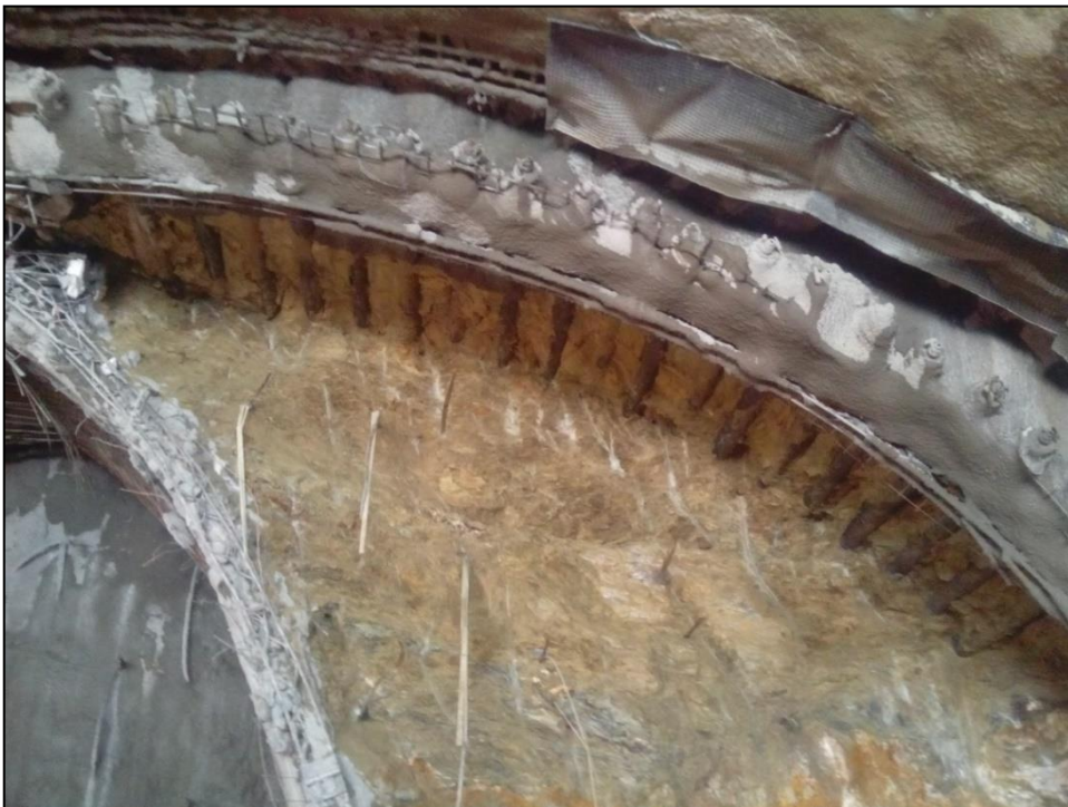
Εικόνα 42 : Μέτωπο εκσκαφής με συνδυασμό υποστήριξης από αγκύρια μετώπου fiberglass και δοκούς προπορείας (Πηγή: Γεωργίου Δ.).
