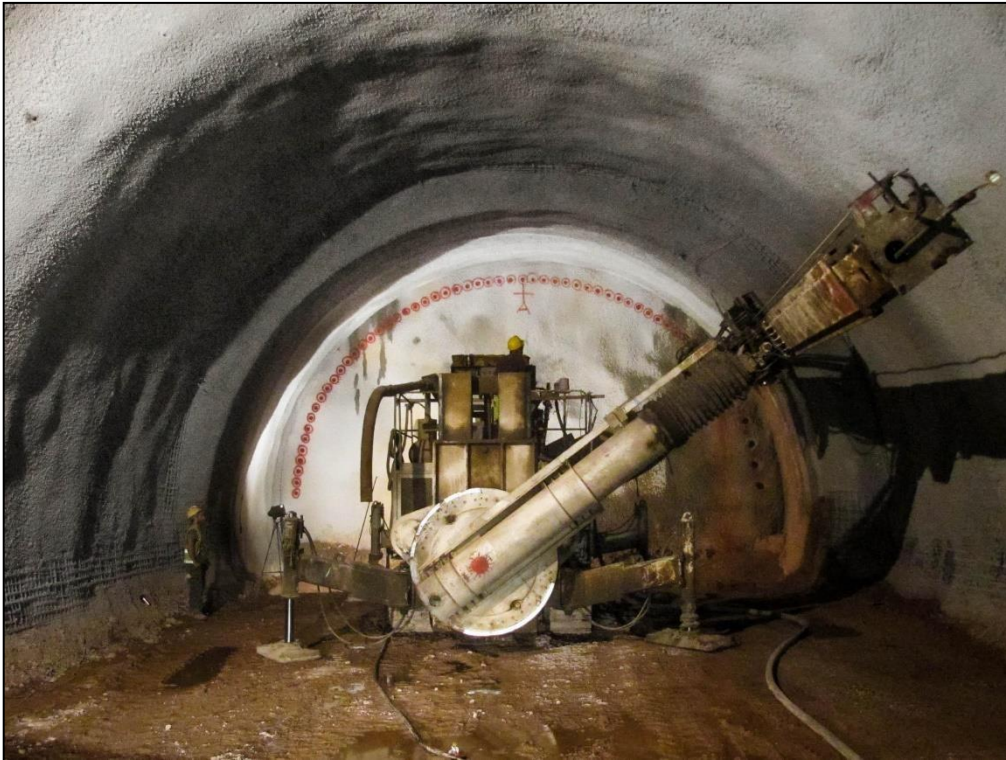
Εικόνα 37 : Διαδικασία κατασκευής ομπρέλας δοκών προπορείας (Πηγή: Γεωργίου Δ.).
