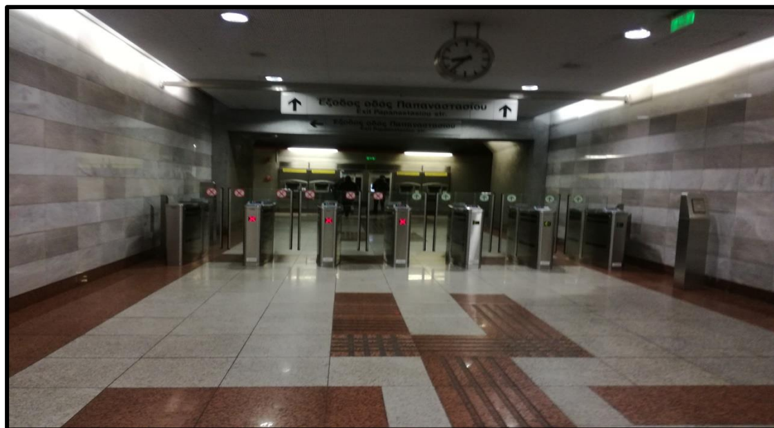
Εικόνα 6.14: ΑΜΕΕ στο επίπεδο των εισιτηρίων του Σταθμού Αιγάλεου προς έξοδο 2 (Οδός Παπαναστασίου)
