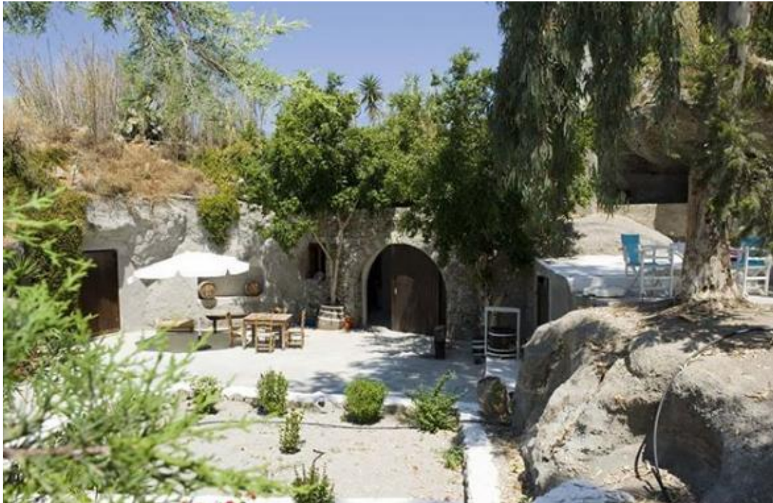
Εικόνα 30. Υπόσκαφο Οινοποιείο Κωσταντάκης – Εξωτερική Άποψη της Κατασκευής (5/9)
