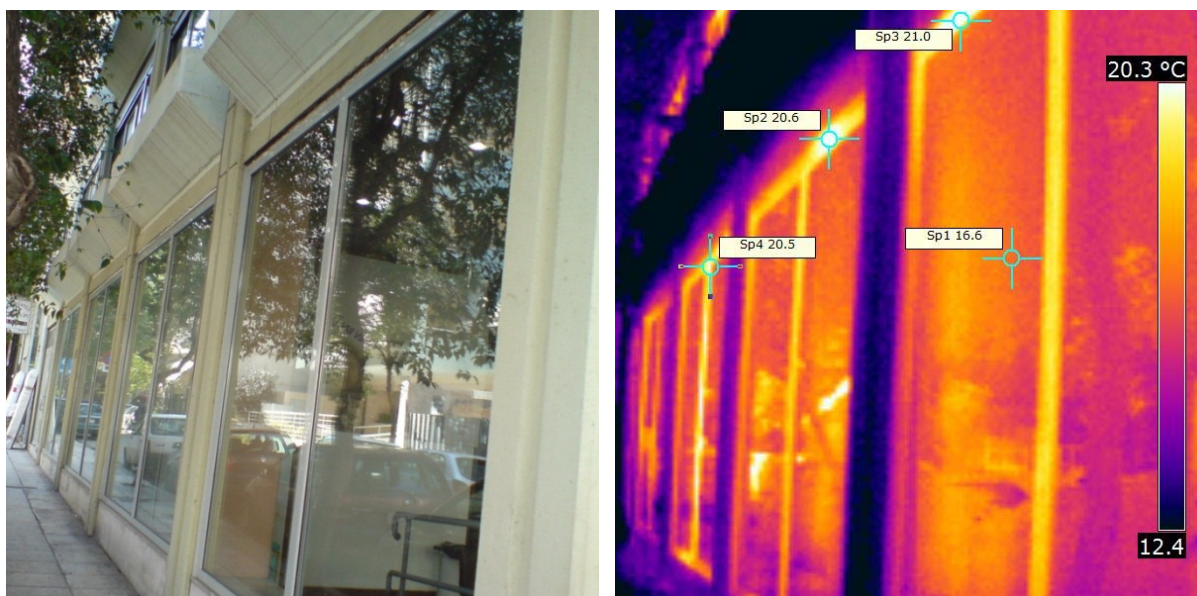
Εικόνα 4.4: Όψη των υαλοπινάκων/κουφωμάτων του ισογείου επί της οδού Αγίου Θωμά
