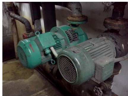
Εικόνα 2.20: Φυγοκεντρικές αντλίες Νοσοκομείου «Παίδων»
