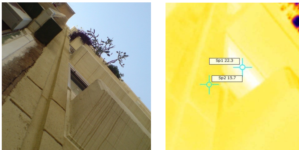
Εικόνα 4.16: Όψη επί της οδού Αγίου Θωμά
