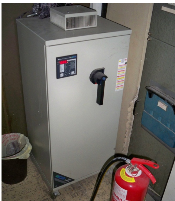
Εικόνα 4.30: Πυκνωτές αντιστάθμισης για τον συντελεστή ισχύος
