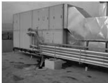
Εικόνα 2.18: Μονάδα επεξεργασίας αέρα [26]
