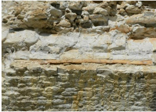
Εικόνα 14. Ξύλινη δοκός ενίσχυσης που παρέμεινε στο ακρόβαθρο μετά την κατάρρευση. ΕΜΠ (2016).
