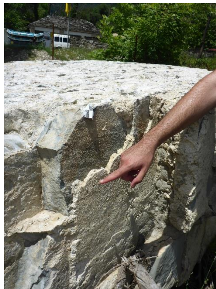
Εικόνα 21. Συμπαγής στρώση κονιαματος ανάμεσα στους θολίτες ενός θραύσματος του κεντρικού τόξου.
