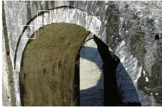
Εικόνα 13. Τα εμφανή σόκορα των τριών από τις τέσσερις ξύλινες ενισχύσεις του ανατλικού τόξου. ΕΜΠ (2016).
