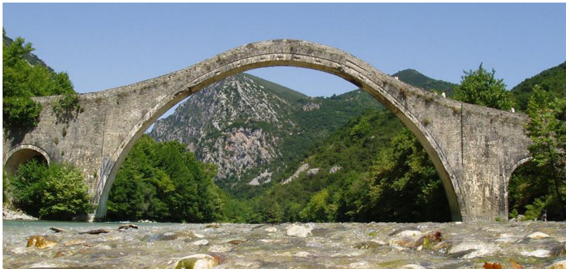
Εικόνα 4. Το Γεφύρι της Πλάκας, στη μορφή που είχε από το 1928 έως το 2015.
