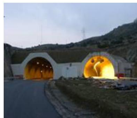
Εικόνα 6.5 Διατομή Cut & Cover στη σήραγγα Καλογερίκου, (Haralampidou et al.)
