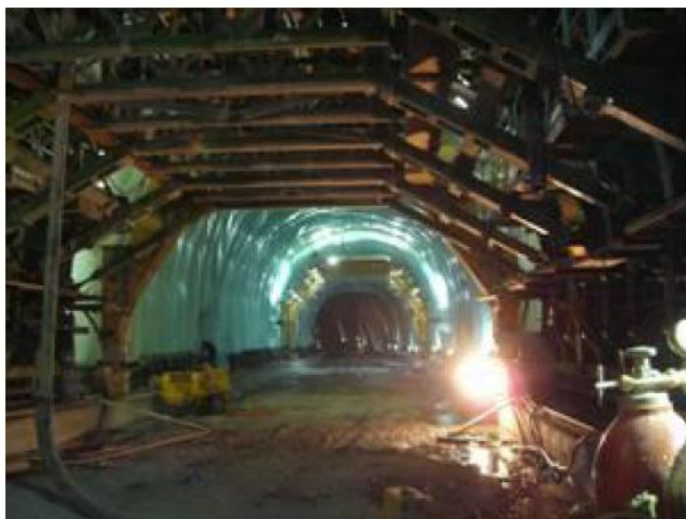
Εικόνα 6.2 Σκυροδέτηση τελικής επένδυσης σε σήραγγα, (Haralampidou et al.)
