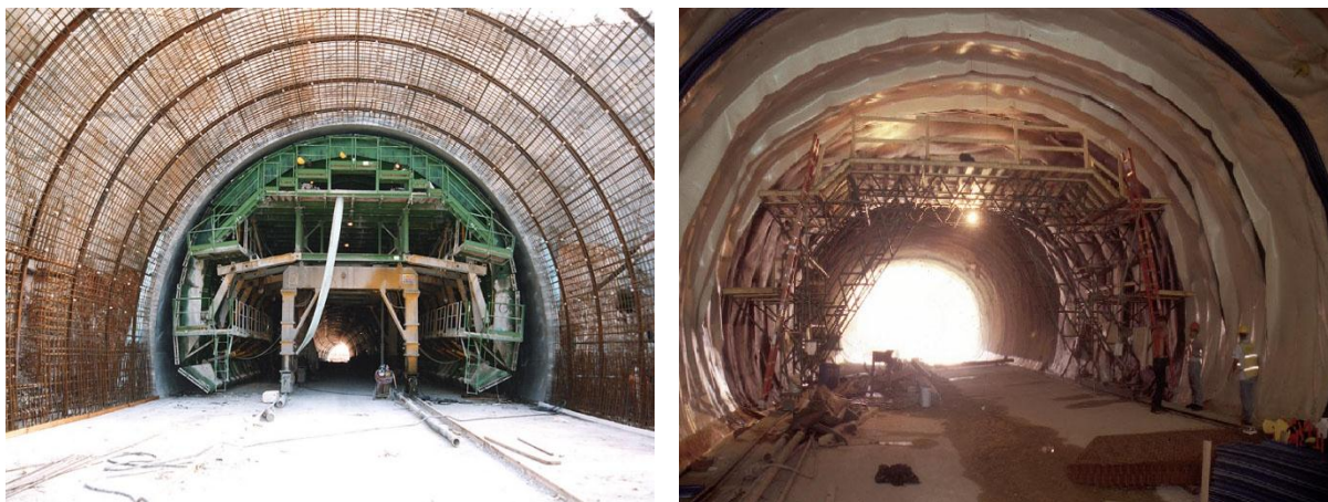
Εικόνα 3.1 Οπλισμός και κατασκευή τελικής επένδυσης σήραγγας
