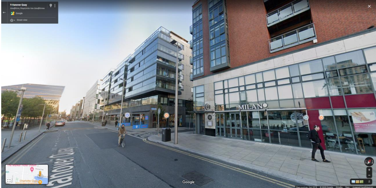
Εικόνα 4.20: Όλα τα κτήρια του τμήματος είναι σε καλή κατάσταση – S6 = 1 (πηγή: Street View)
