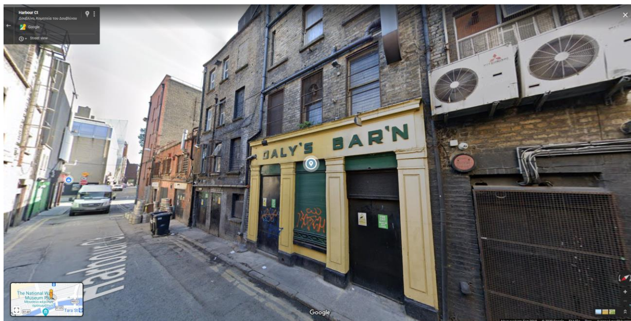
Εικόνα 4.19: Τμήμα με κακή συντήρηση κτηρίων – S6 = 0 (πηγή: Street View)
