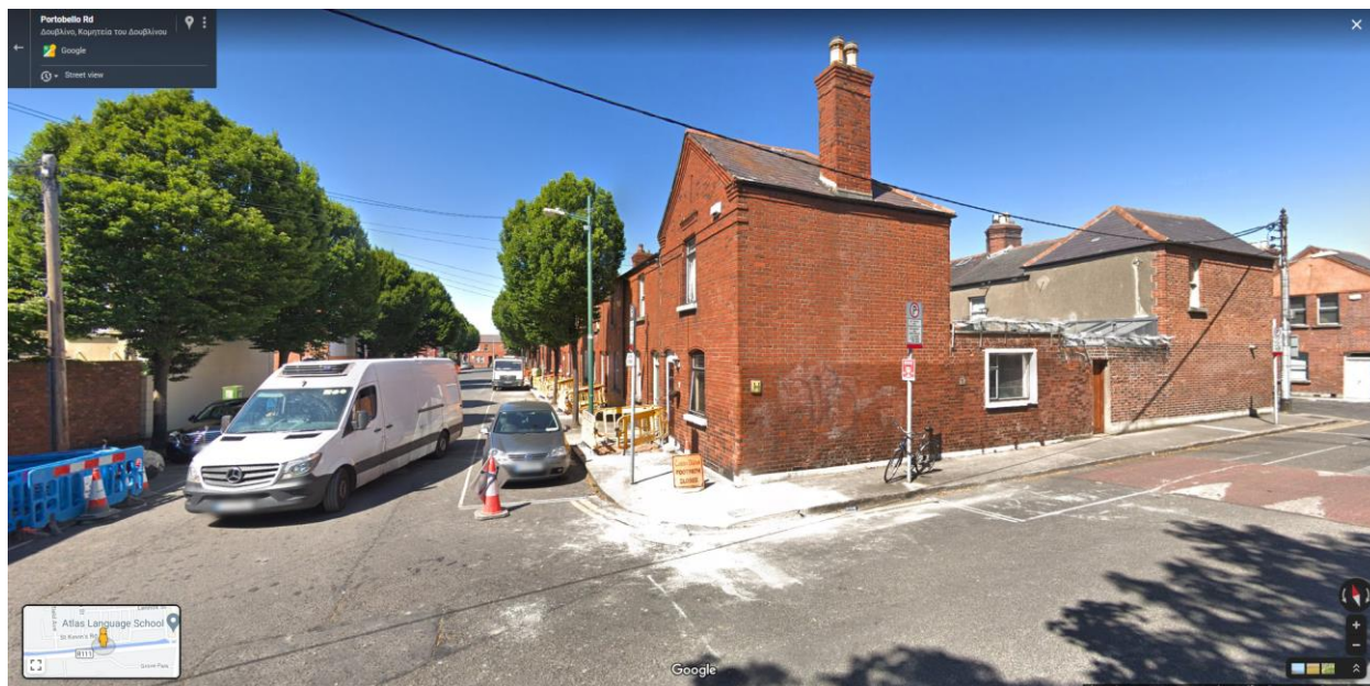
Εικόνα 4.38: Τμήμα όπου εμποδίζεται η κίνηση αναπηρικού αμαξιδίου. – S15 = 0 (πηγή: Street View)
