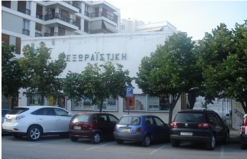
Εικόνα 4.2 Το κτίριο της Εξωραϊστικής. (πηγή: προσωπικό αρχείο).
