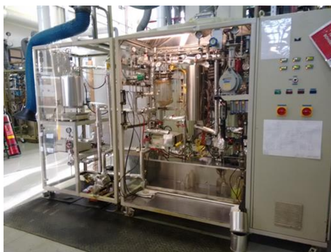
Εικόνα 2: Μονάδα Υδρογονοεπεξεργασίας VB01
