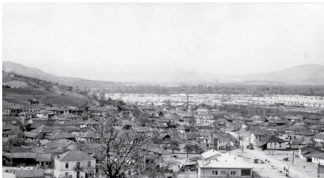
Στο βάθος φαίνονται χιλιάδες προκατασκευασμένα σπίτια για να στεγάσουν τους σεισμόπληκτους Πηγή: Αρχείο Δοξιάδη όπως παρατίθεται στο Αμυγδάλου, Κρητικός και Τσιαμπάος 2018:23
