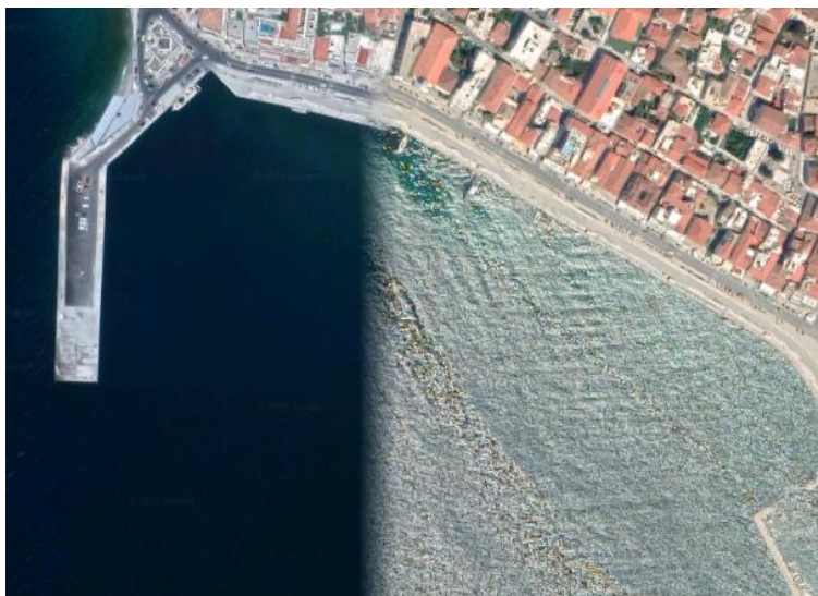
Εικόνα 20: Δορυφορική Κάτοψη Λιμένα Βαθύ
