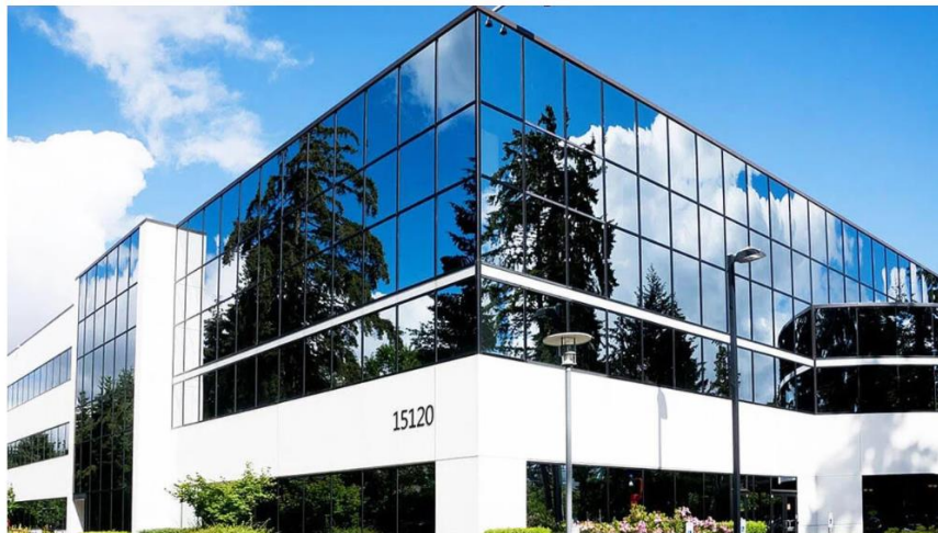
Σχήμα 4.4 Παράδειγμα χρήσης ανακλαστικού υαλοπίνακα [42].
