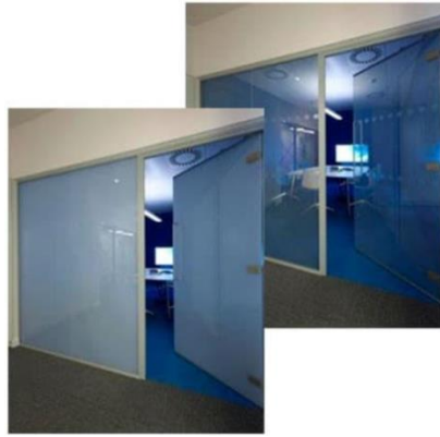
Σχήμα 4.12 Χρήση υαλοπινάκων υγρών κρυστάλλων σε εντός/εκτός λειτουργίας [49].
