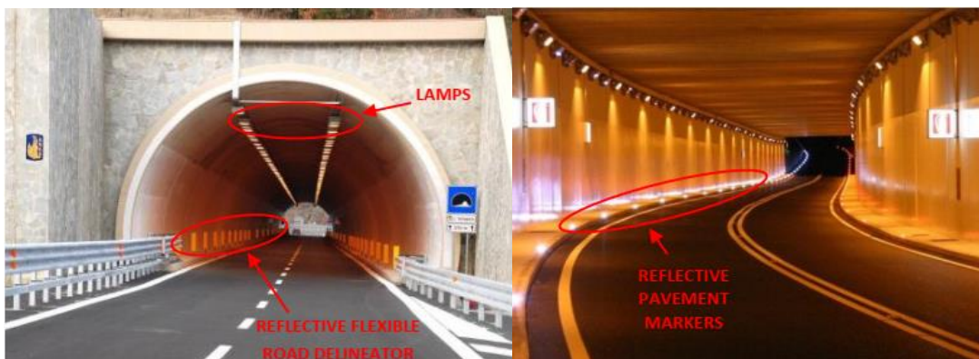
Εικόνα 13: Δευτερεύουσες φωτεινές πηγές, υπεύθυνες για φαινόμενα οπτικής πάλμωσης στη σήραγγα [84]
