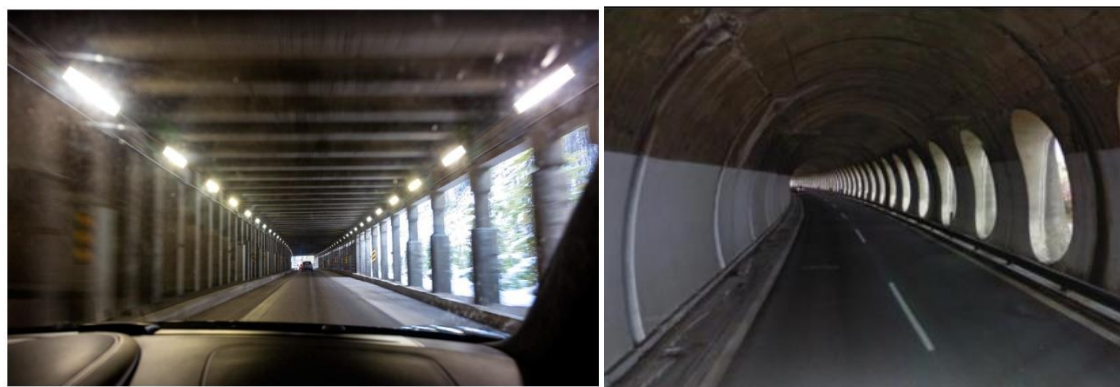
Εικόνα 14: Φαινόμενο οπτικής πάλμωσης σε σήραγγες με ελεύθερα ανοίγματα φυσικού φωτισμού [84][85]
