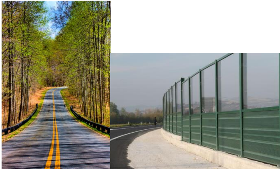
Εικόνα 11: Παραδείγματα φαινομένου οπτικής πάλμωσης σε ανοικτή οδοποιία [84]
