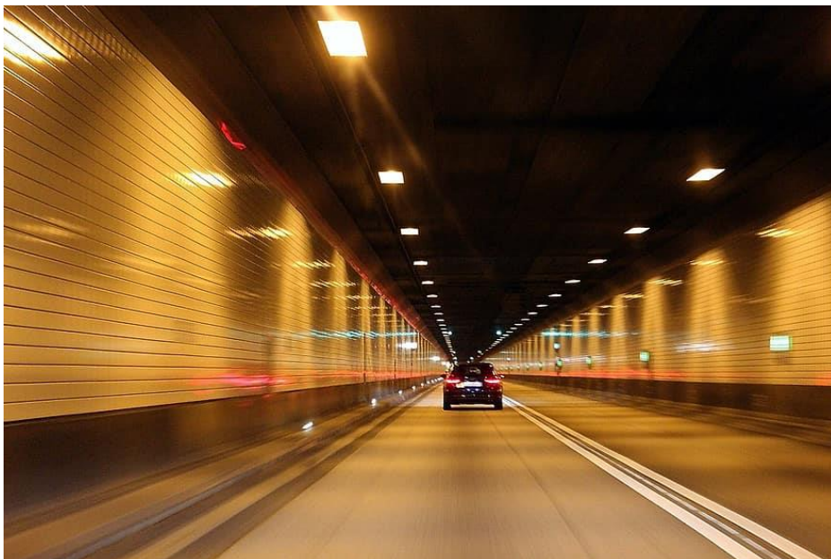
Εικόνα 12: Παραδείγμα φαινομένου οπτικής πάλμωσης σε σήραγγα [84]
