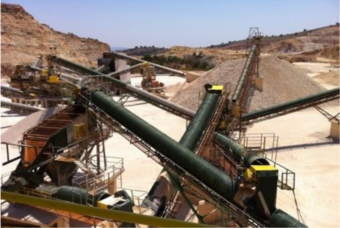
Εικόνα 9: Κεντρική Μονάδα Θραύσης κοσκίνησης
