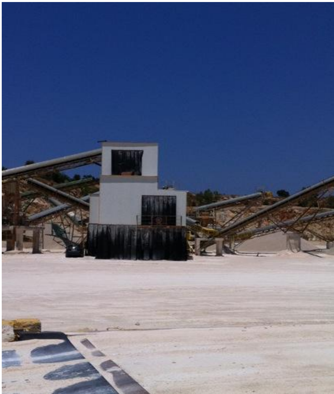
Εικόνα 10: Άλλη όψη των εγκαταστάσεων της εικόνας 9
