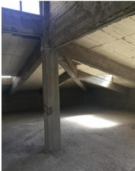
Εικόνα 4.6: Προσθήκη από οπλισμένο σκυρόδεμα στην οροφή του κτιρίου Τσίλλερ.
