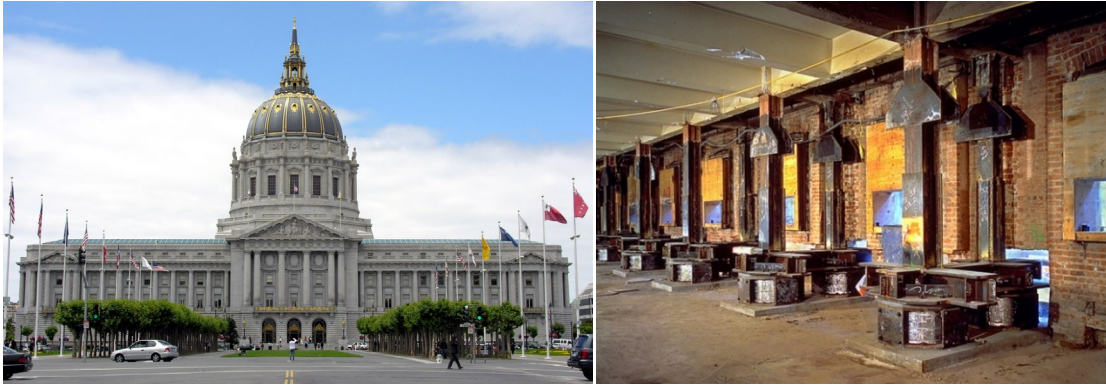
Εικόνα 1.4: (α) San Francisco City Hall [27], (β) Τοποθέτηση μονωτήρων στην περίμετρο [23].
