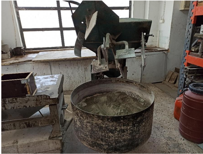
Εικόνα 8.9. Απόθεση υλικών στον αναμεικτήρα για την αρχή της φάσης σκυροδέτησης.
