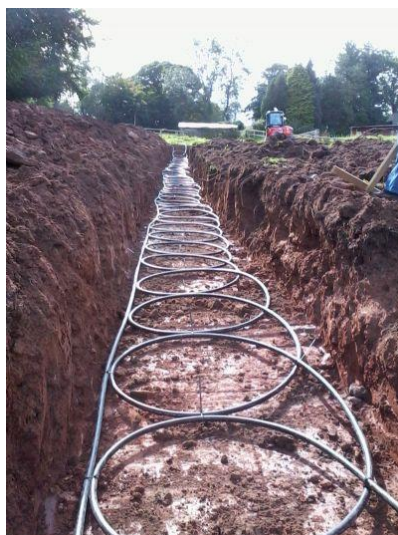
Εικόνα 2.9: Διάταξη οριζόντιου δικτύου [43]
