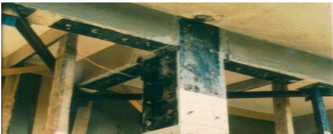
Εικόνα 7.20 : Ενίσχυση κόμβου δοκού-υποστυλώματος με FRP
