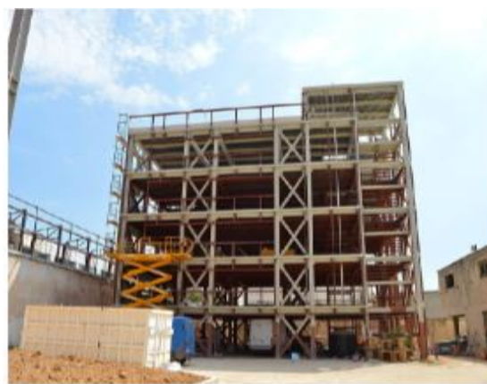
Εικόνα 7.1β :Χιαστί σύνδεσμοι δυσκαμψίας
