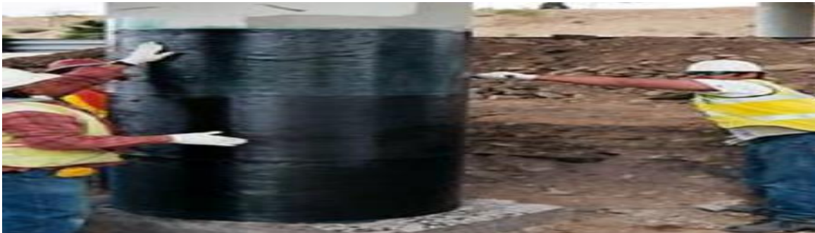
Εικόνα 7.12 : Ενίσχυση υποστυλώματος με μανδύες σύνθετων υλικών
