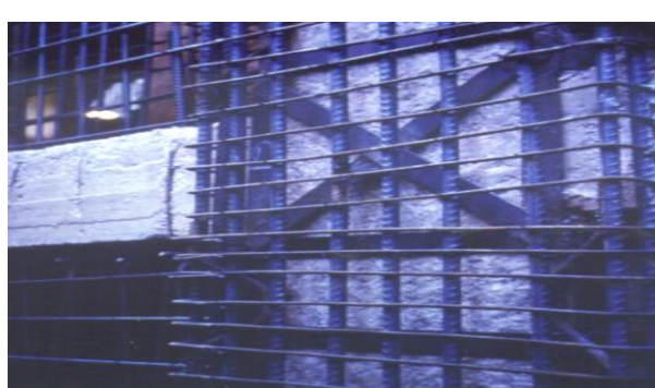
Εικόνα 7.9: Ενίσχυση κόμβου με κλωβούς
