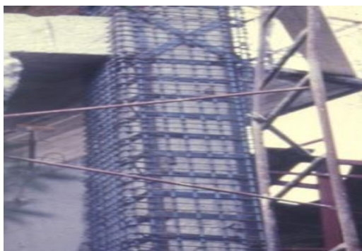
Εικόνα 7.8: Ενίσχυση υποστυλώματος με κλωβούς
