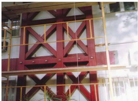
Εικόνα 7.1α :Χιαστί σύνδεσμοι δυσκαμψίας
