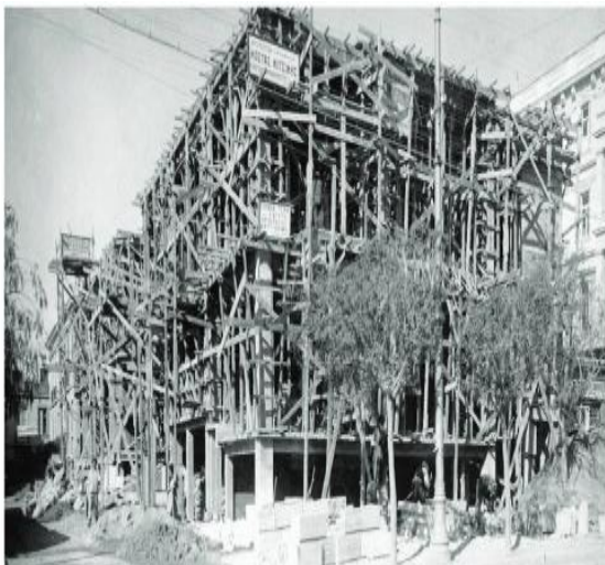
Εικόνα 4: Το κτίριο κατά την ανέγερσή του
