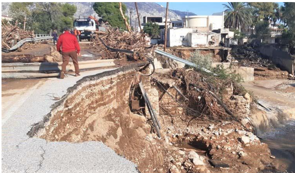
Εικόνα 1.4 Βλάβες του οδικού δικτύου στην Παλαιά εθνική οδό Αθηνών Κορίνθου (ΠΕΟΑΚ) στη γέφυρα του ρέματος Πίκας στην Κινέτα, όπως διαμορφώθηκε μετά την εκδήλωση του πλημμυρικού φαινομένου (Lekkas E., et al., 2019).
