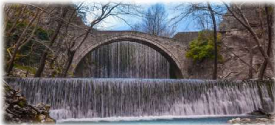
Εικόνα 1.7: Γεφύρι Παλαιοκαρυάς, Τρίκαλα. Χτίστηκε το 1500.
