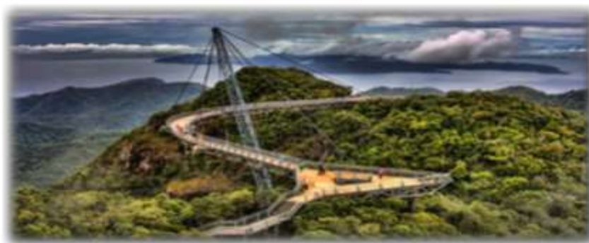
Εικόνα 1.2: Πεζογέφυρα Langkawi Sky-Bridge στη Μαλαισία.
