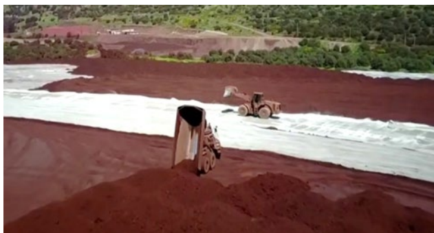
Εικόνα 1. Απόθεση Κ.Β., εργοστάσιο Αγίου Νικολάου
