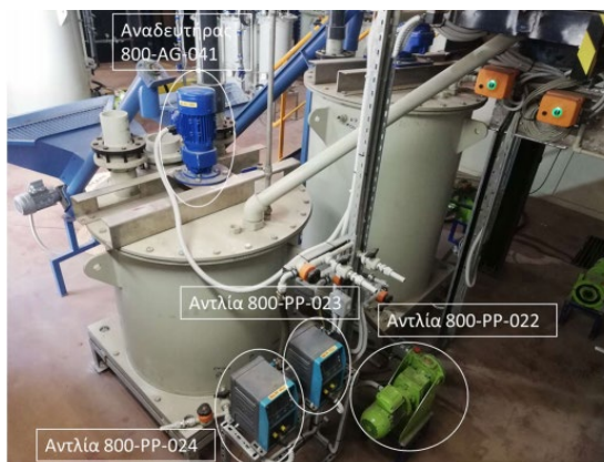
Εικόνα 24. Αναδευτήρας και αντλίες δεξαμενής 800-TK-020
