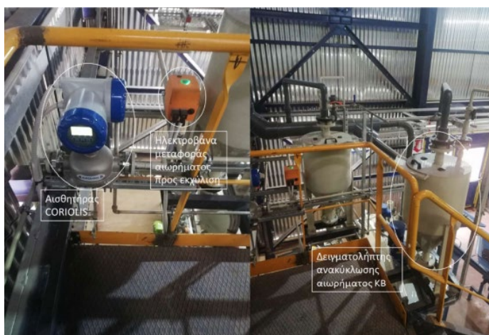
Εικόνα 15. Αισθητήρας CORIOLIS, ηλεκτροβάννα μεταφοράς και δειγματολήπτης
