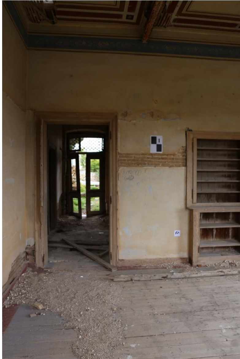
Εικόνα 4. 8: Τοποθέτηση στόχων στο εσωτερικό τμήμα του κτηρίου
