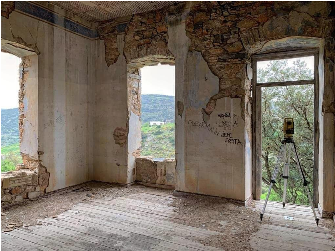
Εικόνα 4. 7: Θέση στάσης S9
