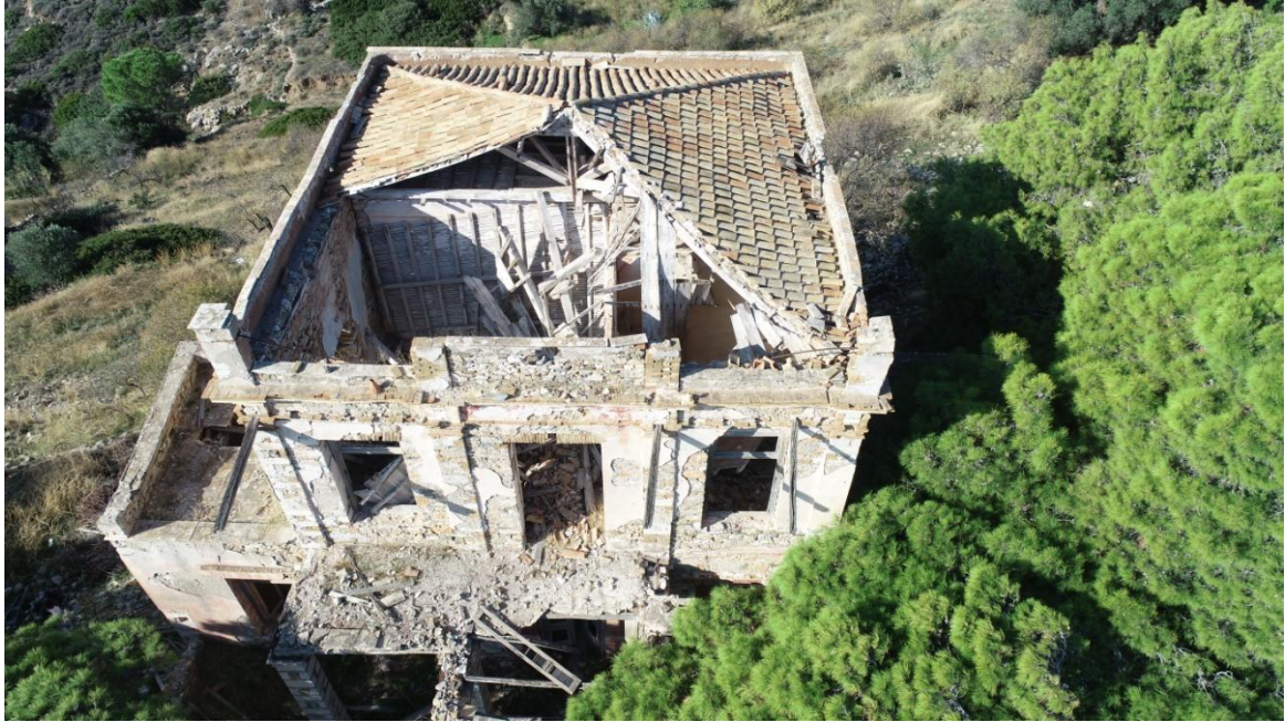
Εικόνα 6. 17: Υφιστάμενη κατάσταση ορόφου
