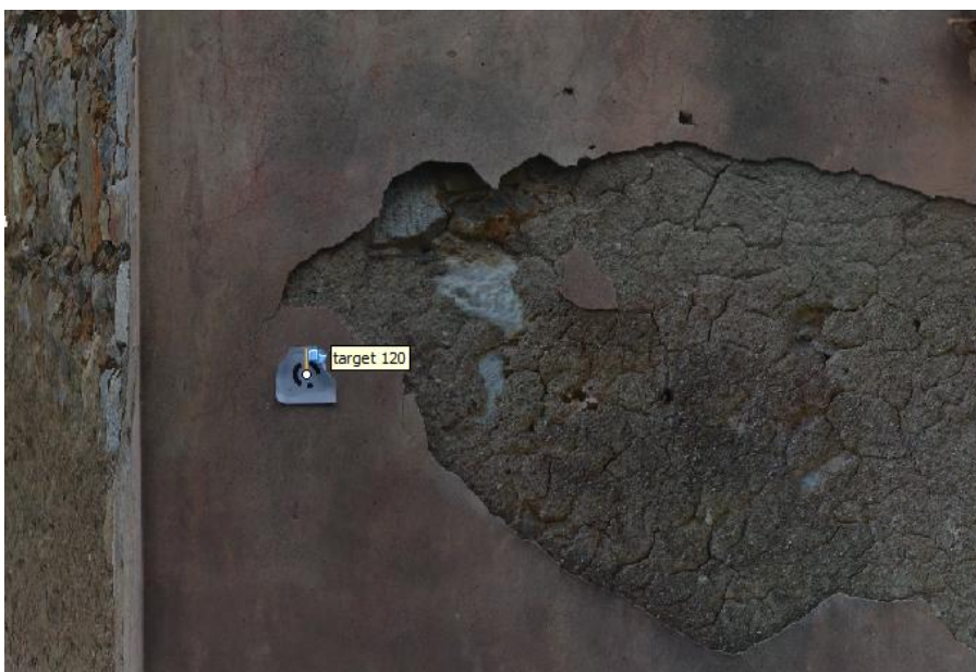
Εικόνα 6. 6: Έλεγχος ορθοφωτογραφιών (απόκλιση 1.59mm)
