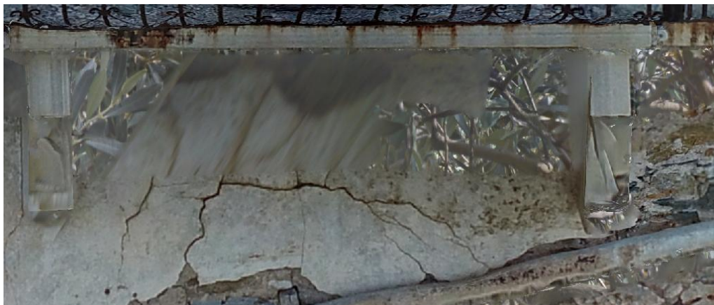
Εικόνα 6. 12: Ορθοφωτογραφία με προβλήματα στην απόδοση υψής λόγω βλάστησης
