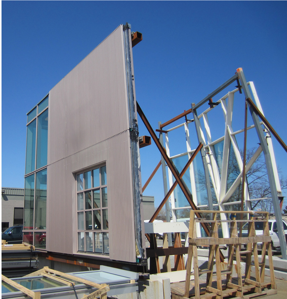
Πάνελ όψεων κατά την τοποθέτηση
