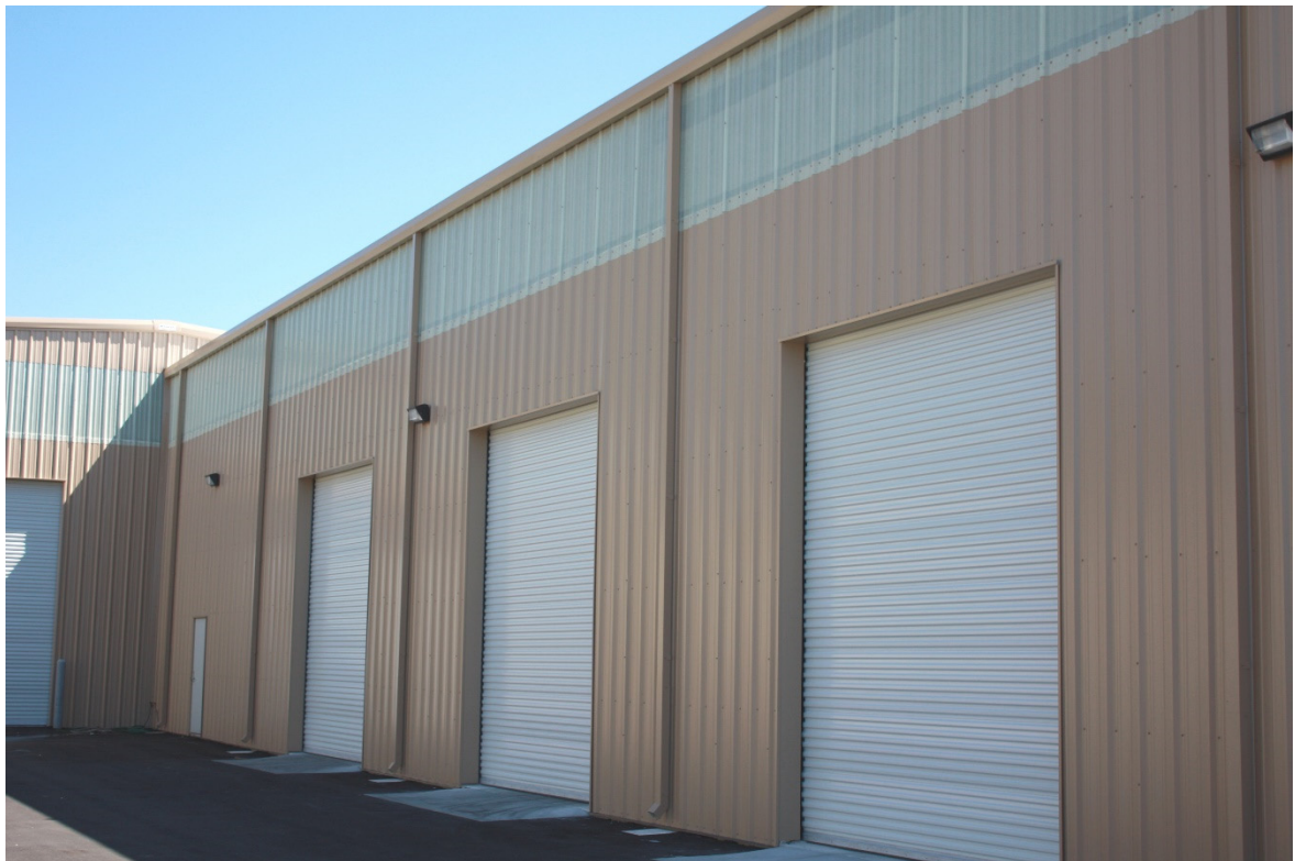
Τελικό αποτέλεσμα με τοίχους πλήρωσης από πάνελ τύπου sandwich
