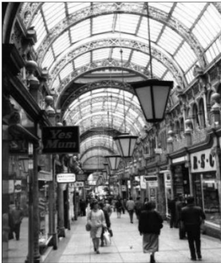
Σχήμα 2.1: Καμπύλο Δικτύωμα Οροφής από Χυτοσίδηρο
