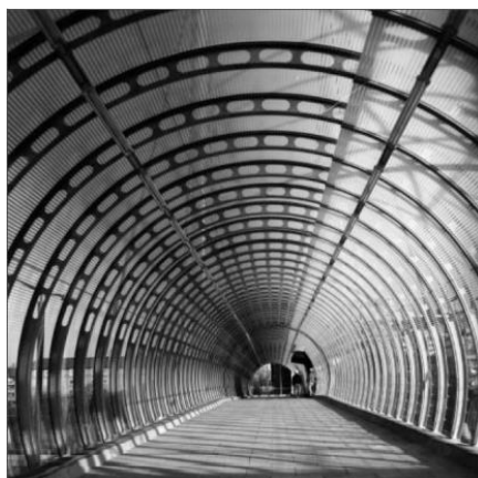
Σχήμα 2.6 : Καμπύλες Μεταλλικές Στηρίξεις για την Κάλυψη πεζογέφυρας
