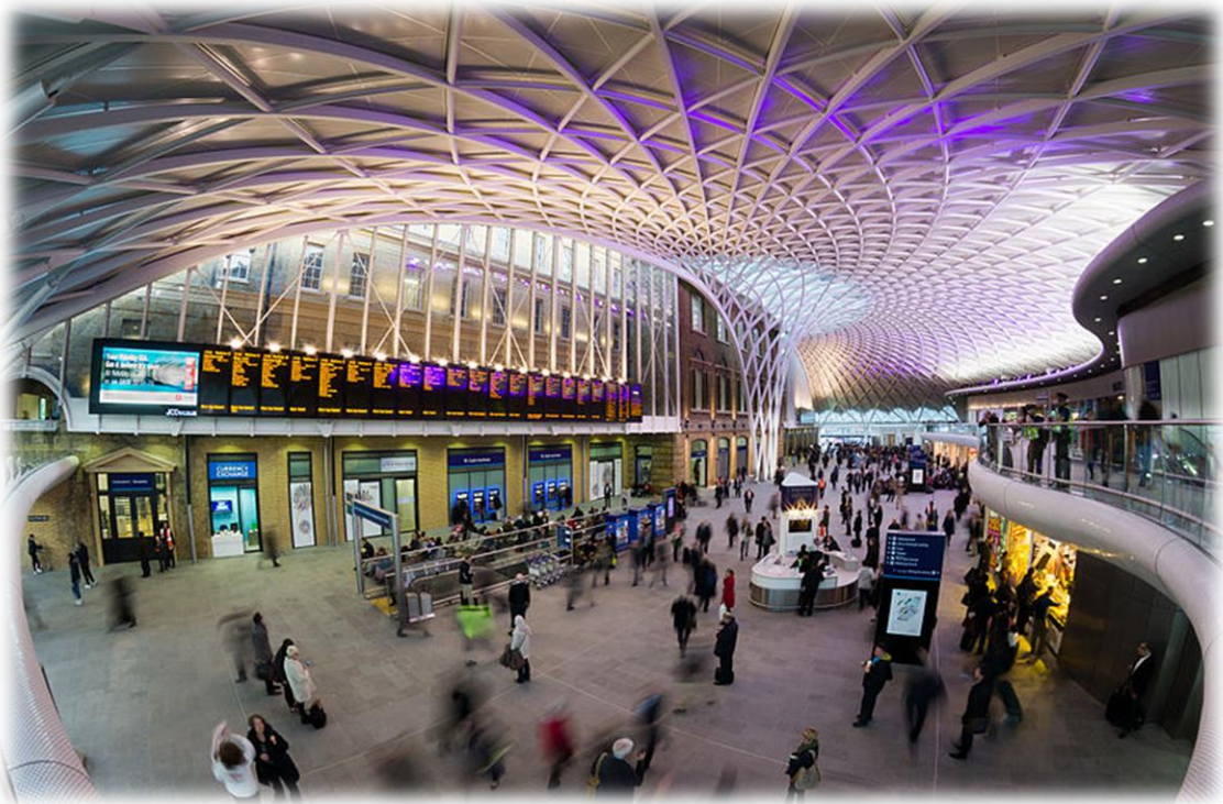
Σχήμα 2.23 : Όψη στεγάστρου στον σταθμό του μετρό King's Cross στο Λονδίνο
