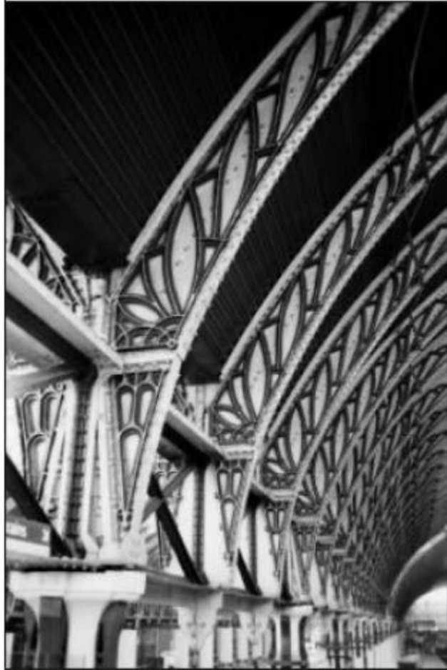
Σχήμα 2.2 : Καμπύλος σφυρήλατος σίδηρος με διακοσμητικές προσθήκες από χυτοσίδηρο
