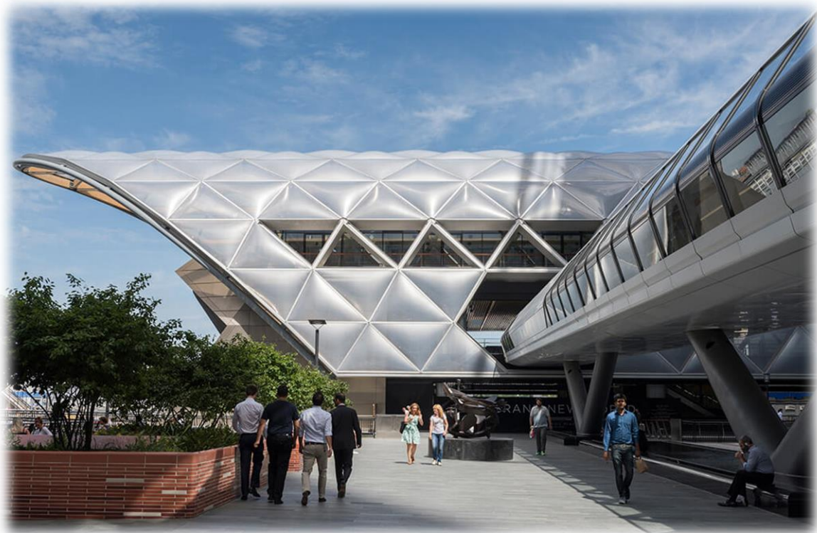
Σχήμα 2.25 : Σταθμός Chary Wharf, Αγγλία, Λονδίνο
