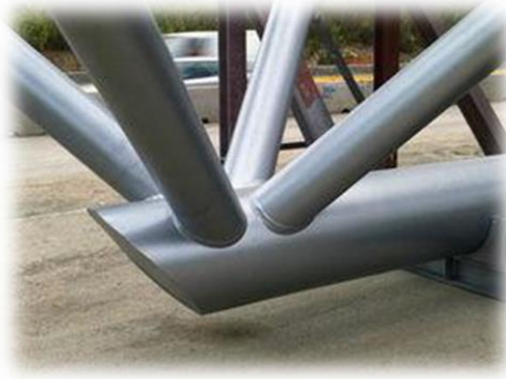
Σχήμα 10.1 : Συγκολλητές αναμονές κόμβου κυκλικών κοίλων διατομών
