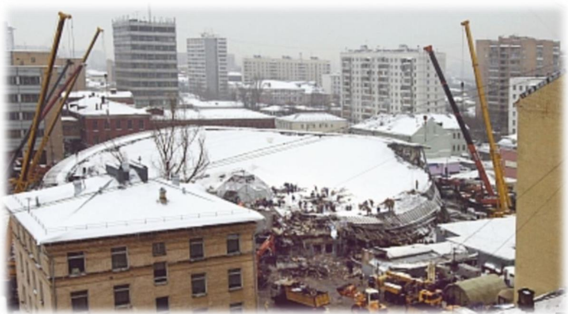
Σχήμα 4.5 : Απροειδοποίητη Αστοχία Στέγης Αγοράς στην Μόσχα λόγω φορτίων χιονιού, με αποτέλεσμα 61 άτομα να χάσουν την ζωή τους.
