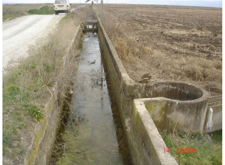
Εικόνες 23,24: Θέση T3.2 – Διαχωριστήρας που μοιράζει το νερό σε Ροδίτσα, Μ. Βρύση και Αυλάκι, αρχή τάφρου T4.
