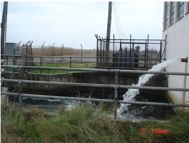
Εικόνες 34, 35: Το νερό αφού αντληθεί οδηγείται σε λεκάνη μετά το κτίριο, από εκεί περνά κάτω από το δρόμο και καταλήγει στην χωμάτινη τάφρο που το οδηγεί στη θάλασσα.
