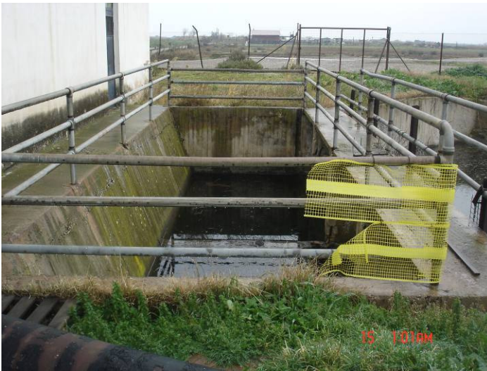
Εικόνες 32, 33: Λεκάνες συγκέντρωσης των όμβριων υδάτων από τα αποστραγγιστικά κανάλια.
