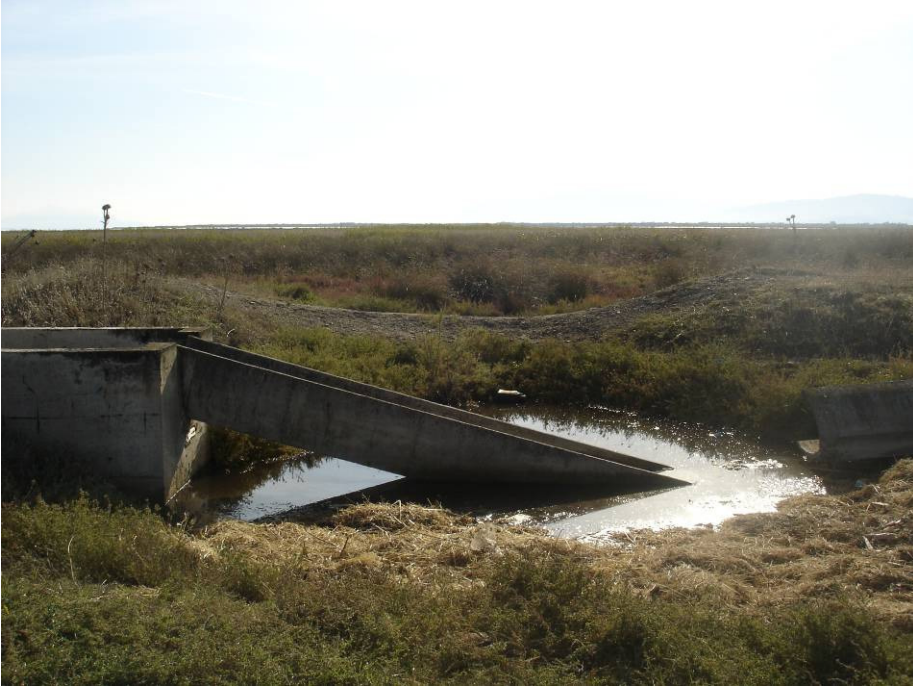
Εικόνα 68: Αστοχία του αναχώματος και τμήματος ενός αρδευτικού καναλιού
