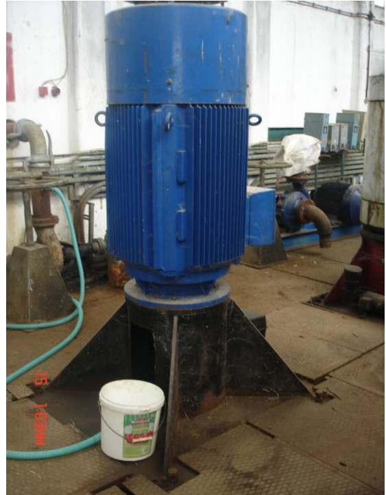
Εικόνα 30: Η αίθουσα που φιλοξενεί 4 αντλίες (δεξιά εικόνα 31 ) ανύψωσης του νερού.
