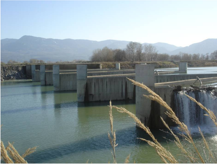
Εικόνα 3: Φράγμα από κατάντη
