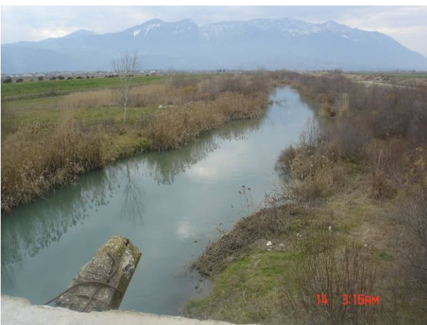
Εικόνα 47: Νέα Κοίτη του Σπερχειού ανάντη της γέφυρας της Ανθήλης (πριν τη σύνδεση με τη Γερμανική Τάφρο – κοντά στο σημείο δειγματοληψίας Th11)
