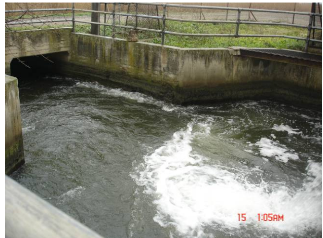
Εικόνες 34, 35: Το νερό αφού αντληθεί οδηγείται σε λεκάνη μετά το κτίριο, από εκεί περνά κάτω από το δρόμο και καταλήγει στην χωμάτινη τάφρο που το οδηγεί στη θάλασσα.
