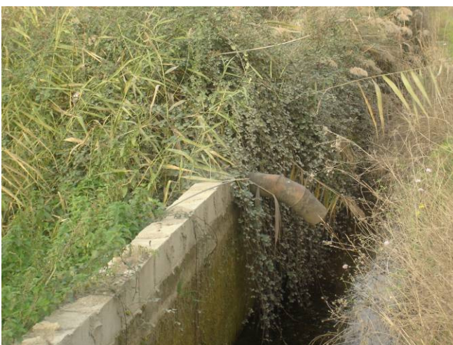
Εικόνα 62: Σωλήνας που μεταφέρει το νερό από τη γεώτρηση και το ρίχνει στο αρδευτικό κανάλι ποτίσματος.
