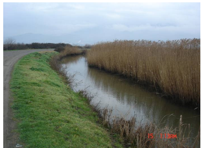
Εικόνες 37, 38: Χωμάτινη τάφρος που οδηγεί τα όμβρια μετά από 1 km στη θάλασσα του Μαλιακού κόλπου. (Σημείο δειγματοληψίας Th8)
