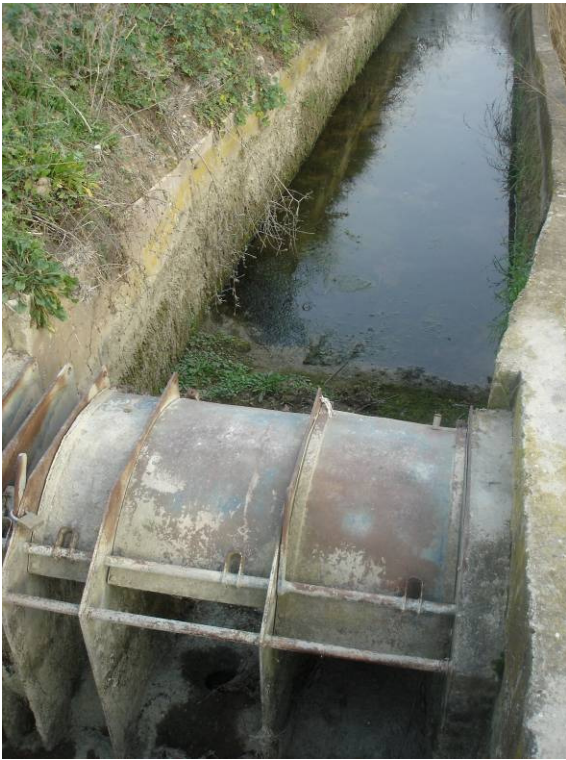
Εικόνες 23,24: Θέση T3.2 – Διαχωριστήρας που μοιράζει το νερό σε Ροδίτσα, Μ. Βρύση και Αυλάκι, αρχή τάφρου T4.
