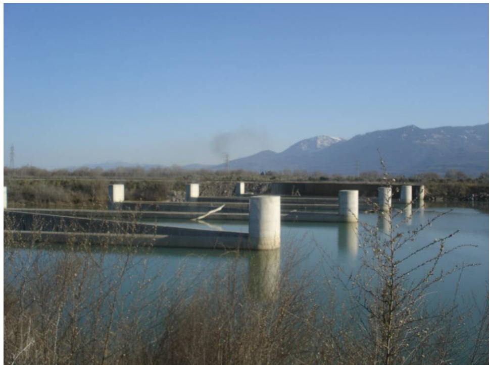
Εικόνα 2: Φράγμα από ανάντη
