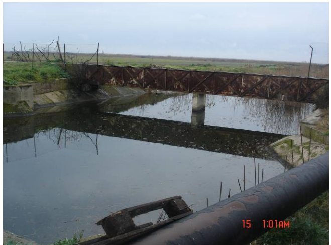
Εικόνες 32, 33: Λεκάνες συγκέντρωσης των όμβριων υδάτων από τα αποστραγγιστικά κανάλια.
