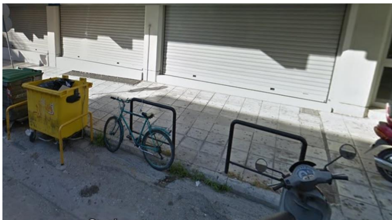
Εικόνα 3.20 Στο υπό εξέταση τμήμα το πεζοδρόμιο δεν έχει εμφανής φθορές S10=1 (Πηγή: Street View)
