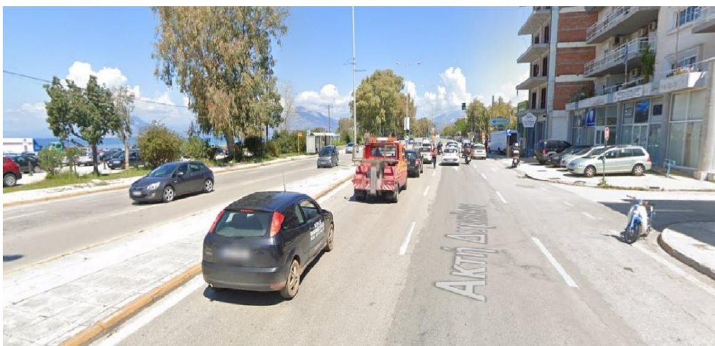
Εικόνα 3.25 Στο υπό εξέταση τμήμα υπάρχουν περισσότερες από 4 λωρίδες κυκλοφορίας S14=0 (Πηγή: Street View)
