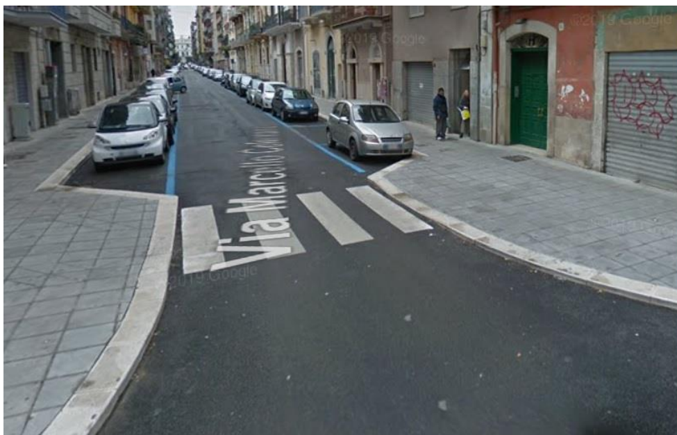
Εικόνα 3.32 Στο υπό εξέταση τμήμα υπάρχει ράμπα και στα δύο άκρα C1_2=2 (Πηγή: Street View)
