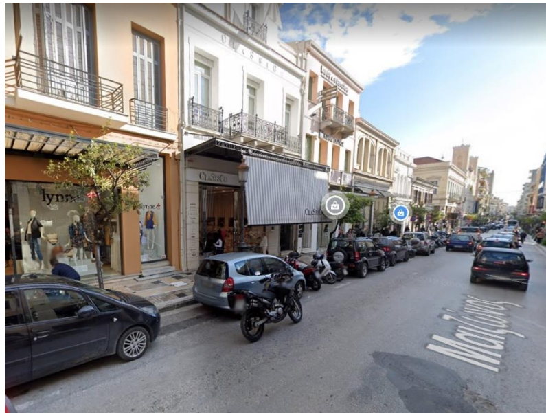
Εικόνα 3.12 Στο υπό εξέταση τμήμα δεν υπάρχουν εμφανής φθορές στα κτίρια S6=1 (Πηγή: Street View)
