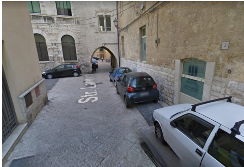
Εικόνα 3.17 Στο υπό εξέταση τμήμα δεν υπάρχει πεζοδρόμιο S9=0 (Πηγή: Street View)
