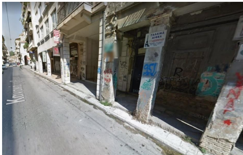
Εικόνα 3.11 Στο υπό εξέταση τμήμα υπάρχουν εμφανής φθορές στα κτίρια S6=0 (Πηγή: Street View)
