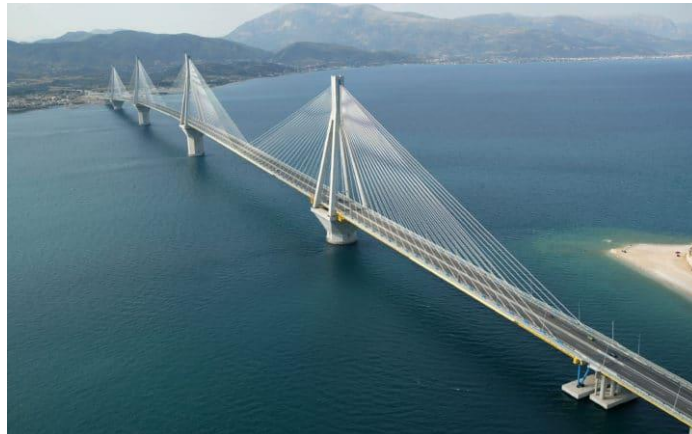
Εικόνα 4.1.2.2 Γέφυρα Ρίου – Αντιρρίου (ελλάκτωρ)
