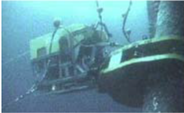
Εικόνα 5-4. Κοπή με εκτόξευση διαβρωτικής δέσμης νερού (Pors, Verbeeck, Wurplel, & Briët, 2011)
