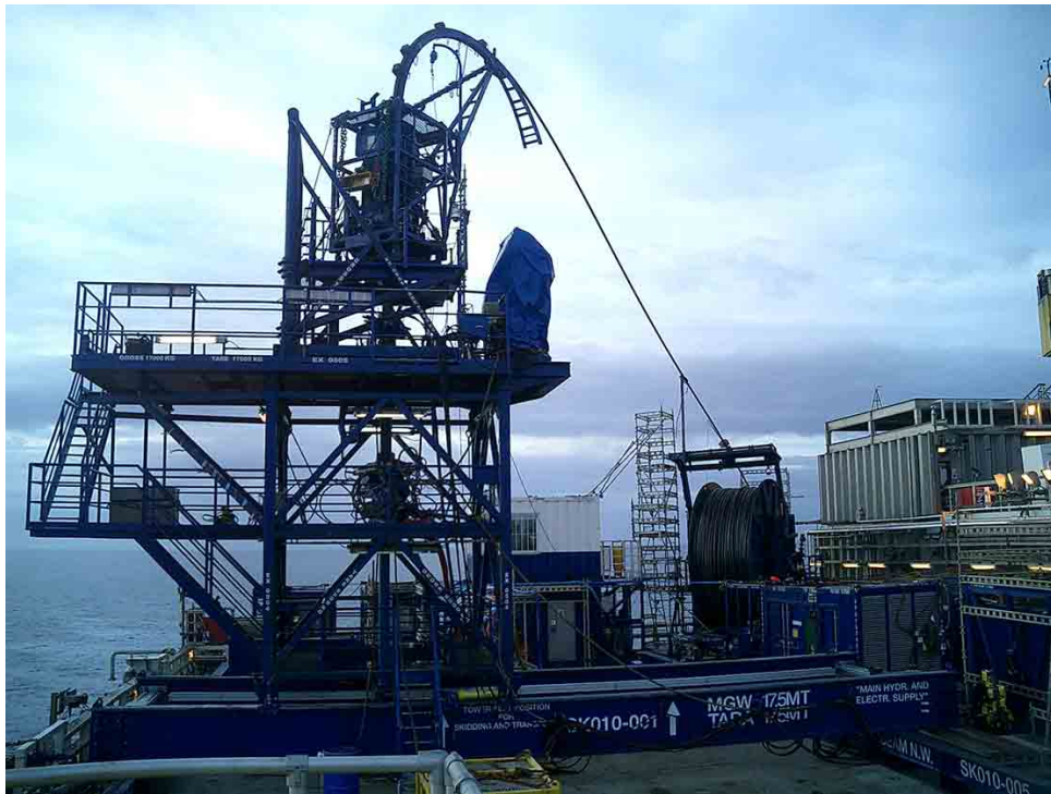
Εικόνα 4-25. Μονάδα coiled tubing σε υπεράκτια εξέδρα (Schlumberger, 2020)
