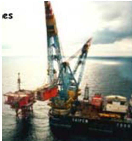
Εικόνα 5-2. Απομάκρυνση των εξάλων της εξέδρας Odin, βάρους 7.700 τόνων σε δομοστοιχεία (Pors, Verbeeck, Wurpel, & Briët, 2011)
