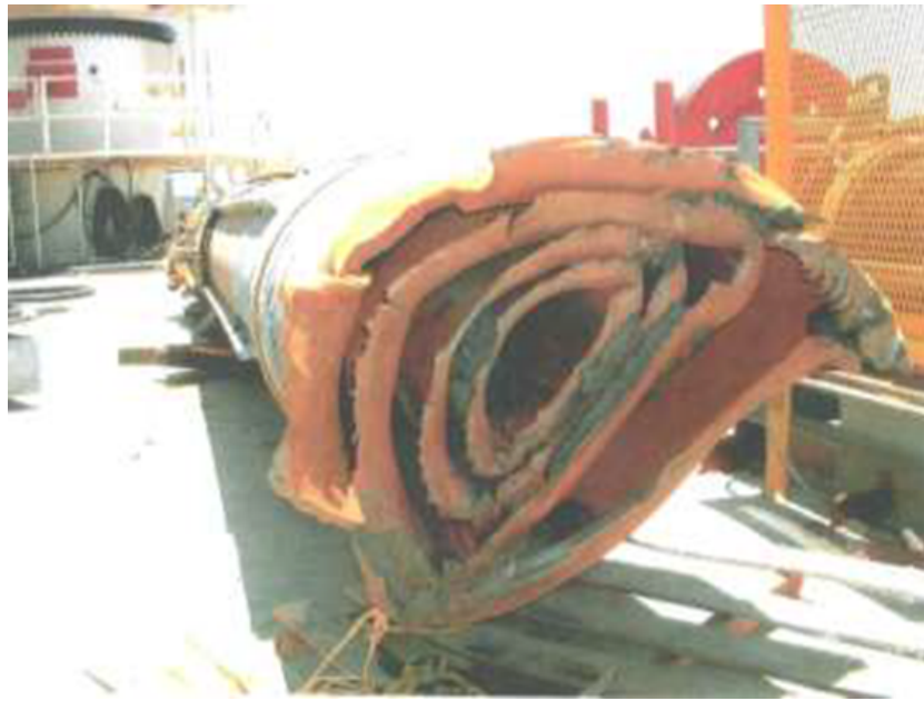
Εικόνα 5-13. Αποκοπή πολλαπλών στηλών σωλήνωσης κάτω από τον πυθμένα της θάλασσας με χρήση υδραυλικού ψαλιδιού μετάλλων (Grismala, 2015)
