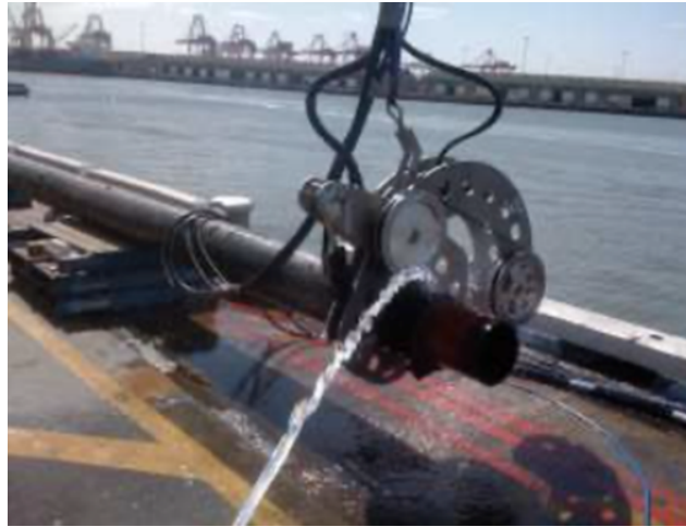
Εικόνα 5-9. Σύστημα συρματοκοπής με αδαμαντοφόρο σύρμα (diamond wire cutting system) (Grismala, 2015)
