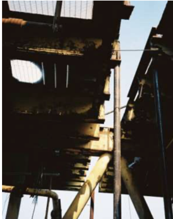
Εικόνα 5-3. Διαχωρισμός καταστρώματος σε τμήματα για την απομάκρυνσή του (Grismala, 2015)
