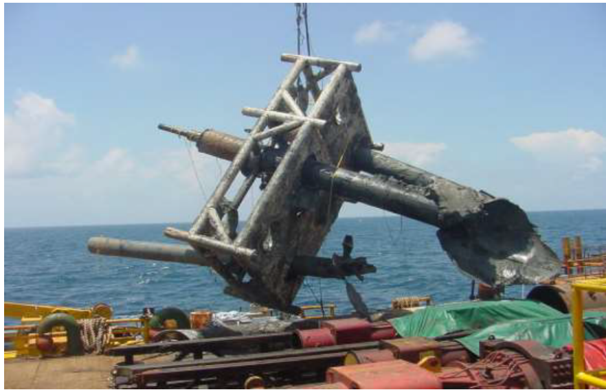
Εικόνα 5-6. Απομάκρυνση υποθαλάσσια βάσης (template) με χρήση εκρηκτικών (Grismala, 2015)
