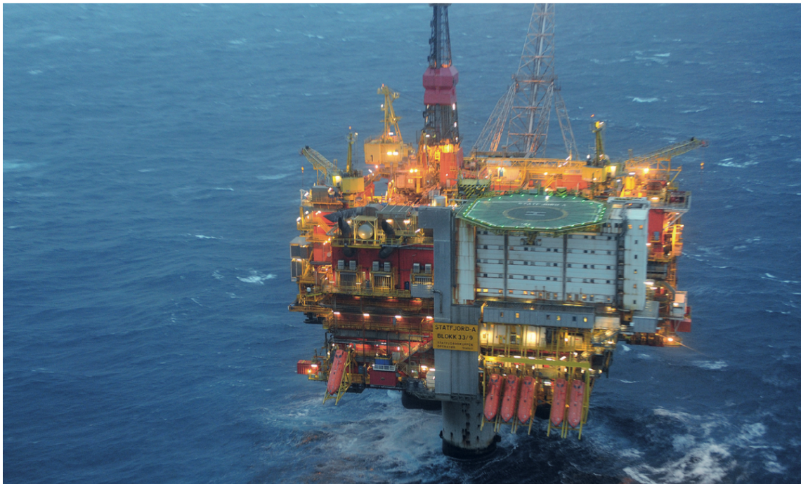
Εικόνα 3-1. Η εξέδρα Statfjord A στη Βόρεια Θάλασσα (UK Oil and Gas Industry Association Limited, 2019)
