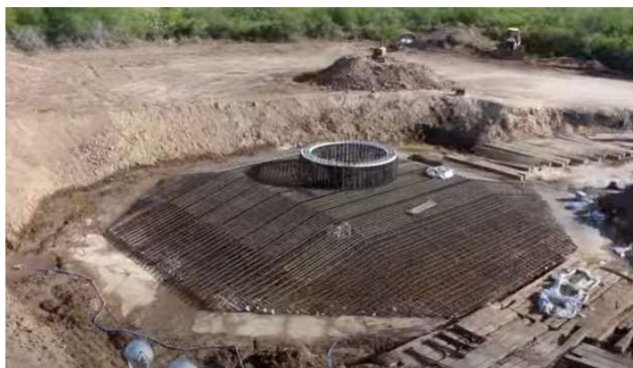
Εικόνα 12. Ενδεικτική θεμελίωση χερσαίας ανεμογεννήτριας
