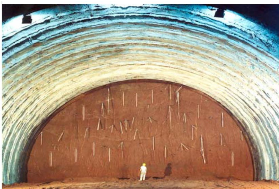
Σχήμα 24: Προενίσχυση μετώπου με αγκύρια fiberglass
