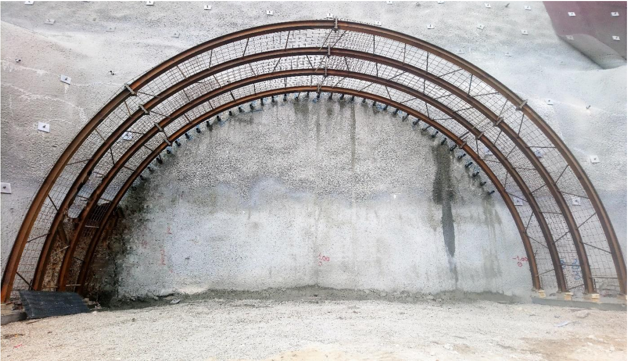
Σχήμα 25: Στήριξη ομπρέλας Forepole στο Βόρειο Μέτωπο Εξόδου της Σήραγγας Σ2.1 του κάθετου άξονα 70 Εγνατίας Οδού
