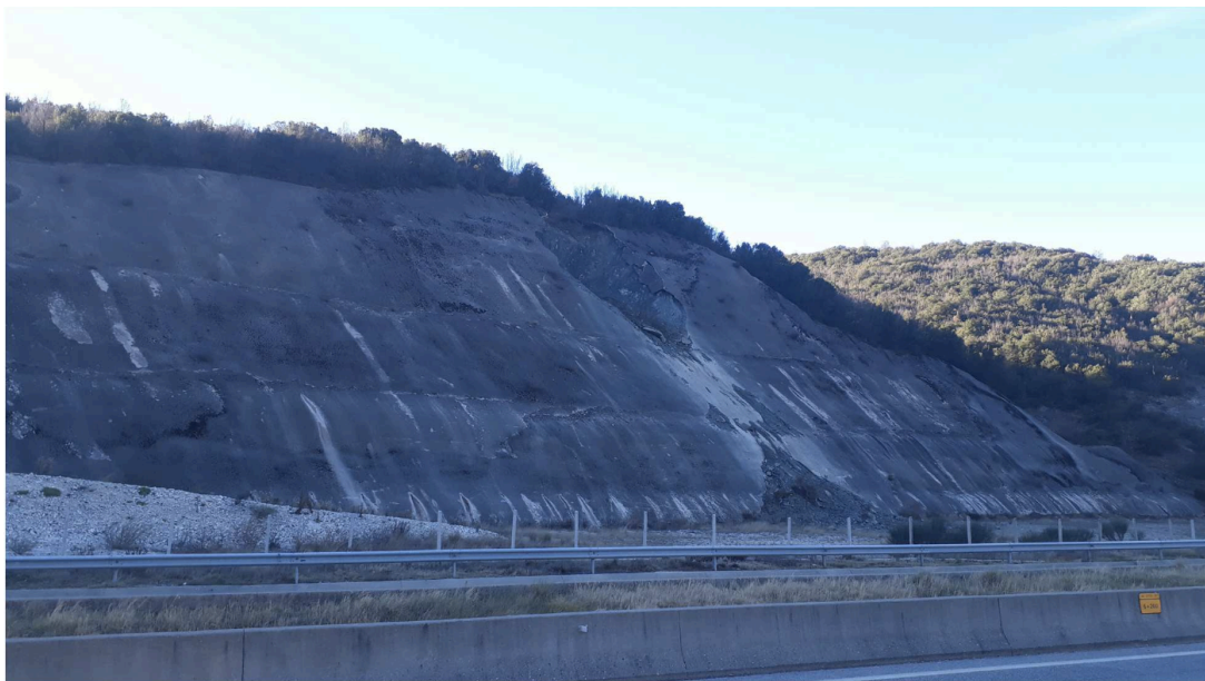
Εικόνα 70: Φωτογραφία από αυτοψία των μηχανικών που καταδεικνύει τις τμηματικές ολισθήσεις του πρανούς
