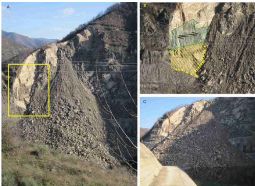
Εικόνα 5: Σύνθετη αστοχία όγκου 333.000m 3 (2008)
