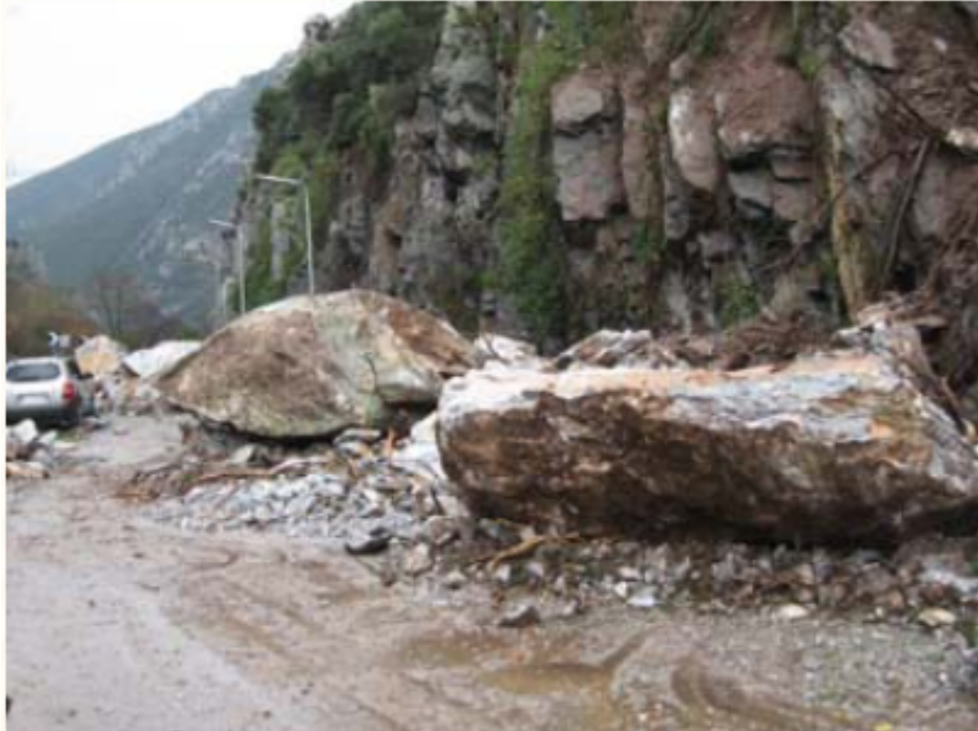
Εικόνα 4: Καταπτώσεις βράχων Τέμπη (2009)
