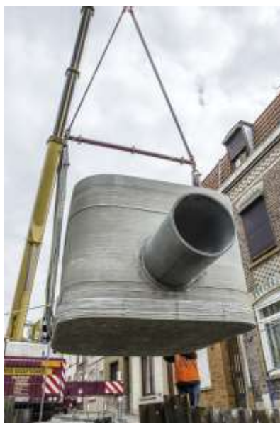
Σχήμα 5-11: Επιτόπου εργασίες ανύψωσης και τοποθέτησης.
