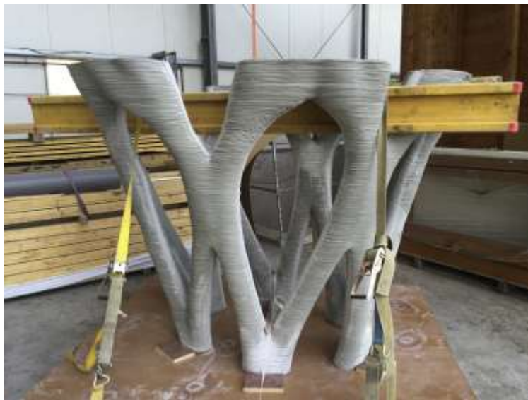
Σχήμα 5-7: Διάταξη του ξυλότυπου με τα εξωτερικά στηρίγματα πριν την αφαίρεση τους
