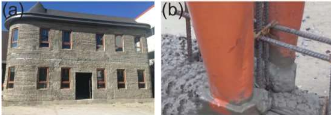
Σχήμα 4-2: Διώροφη εξοχική κατοικία που εκτυπώθηκε από την εταιρεία Huashang Tengda (a) και το τμήμα του ακροφυσίου που χρησιμοποιήθηκε επί τόπο (b)
