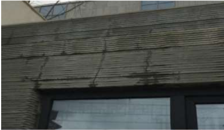
Σχήμα 4-12: Ανάπτυξη ρηγμάτωσης μεταξύ τυπωμένων στρώσεων σκυροδέματος
