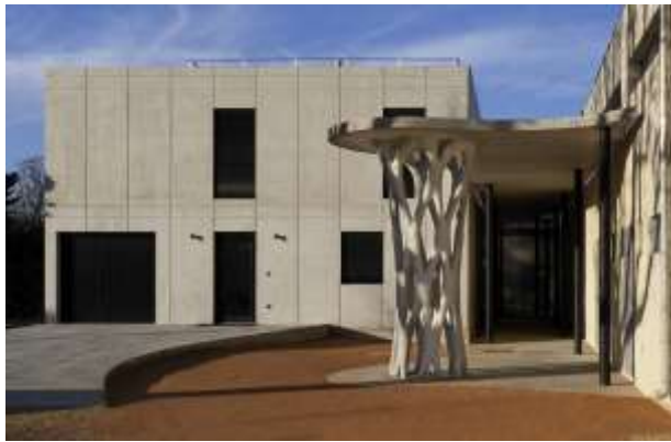
Σχήμα 5-1: Υποστύλωμα ελεύθερου σχήματος στην πόλη Aix-en-Provence.
