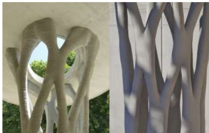
Σχήμα 5-8: Σύγκριση του υποστυλώματος πριν και μετά το επιφανειακό φινίρισμα
