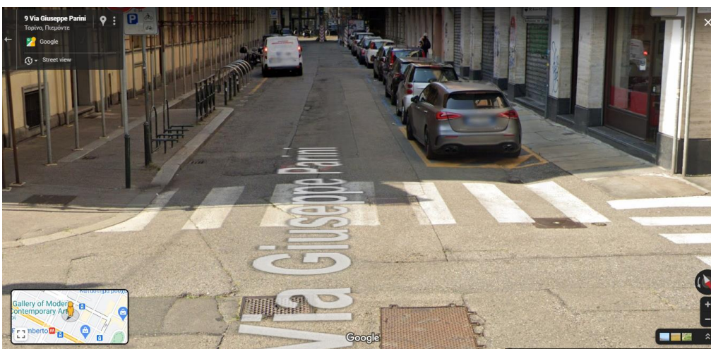
Εικόνα 3. 42: Τμήμα με μεταβλητή C1\_2=2 (Πηγή: Street View)
