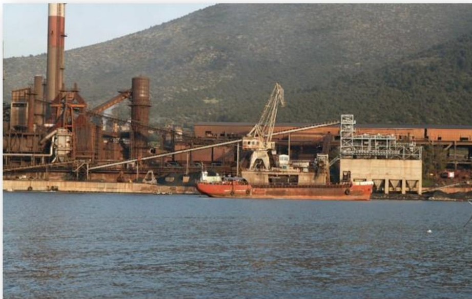
Εικόνα 3: Οι μεταλλουργικές εγκαταστάσεις στη Λάρυμνα
