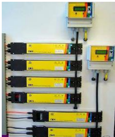
Εικόνα 14: Αντιστροφείς για ενσωμάτωση σε Φ/Β πάνελ
