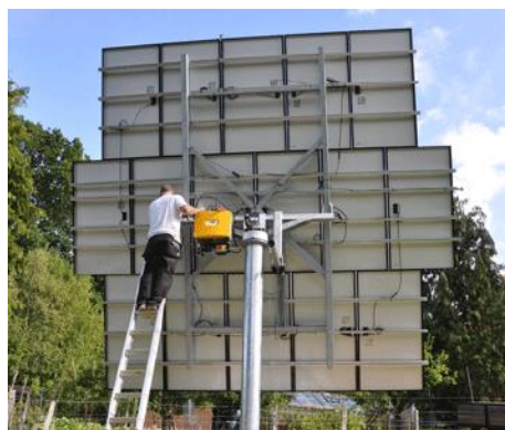
Εικόνα 11: Σύστημα ιχνηλάτησης της πορείας του ήλιου μονού άξονα (αριστερά). Σύστημα ιχνηλάτησης της πορείας του ήλιου διπλού άξονα
