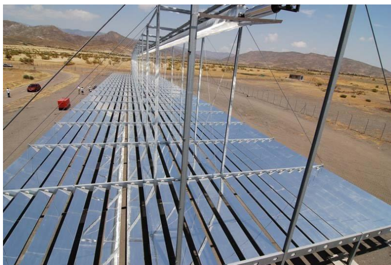
Σχήμα 2.15: Τυπικός συλλέκτης τύπου Fresnel [2.18]
