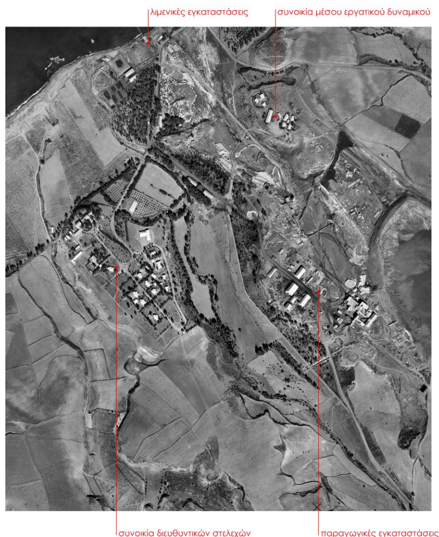
Εικ. 4.49. Οι εγκαταστάσεις της Λίμνης όπως αποτυπώθηκαν σε αεροφωτογραφία του 1963 (Τμ. ζηματολογίου και χωρομετρίας).
