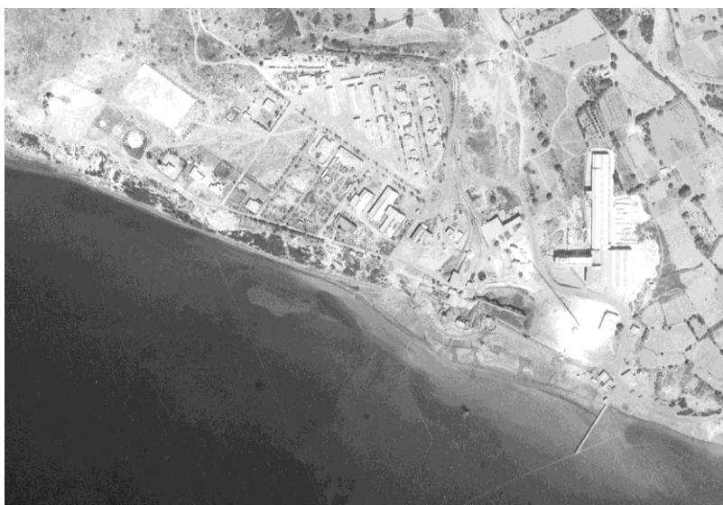
Εικ. 4.28. Οι εγκαταστάσεις της ΕΜΕ στο Βασιλικό όπως αποτυπώθηκαν σε αεροφωτογραφία του 1957 (Τμ. Κτηματολογίου και Χωρομετρίας).
