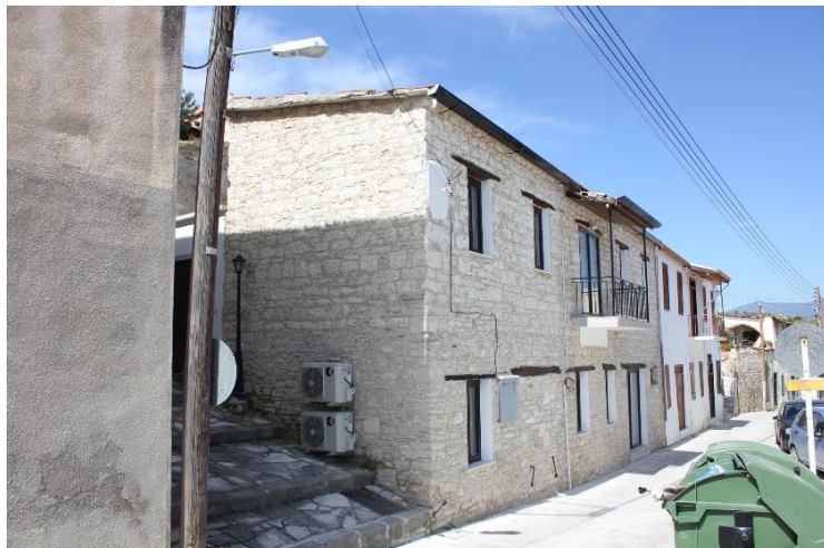
Εικ. 3.21. Το κτήριο στο οποίο στεγάστηκαν οι υποδομές υγείας της ΑΕΕΧΠΛ στην Καλαβασό, 2019 (συλλογή συγγραφέα).
