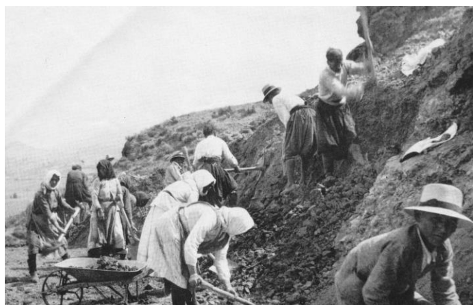
Εικ. 2.95. Οικοδομικές εργασίες για την κατασκευή κατοικίας ανώτερου στελέχους της CMC εκτελούμενες από άνδρες και γυναίκες στη Σκουριώτισσα, 1924 (Charles F. και Ruby L. Jackson, συλλογή William J. Everett).
