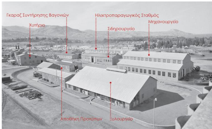
Εικ. 2.42.* Άποψη εγκαταστάσεων της CMC στην μεταλλουργική και εξαγωγική ζώνη του Ξερού, 1950s (Γραφείο Τύπου και Πληροφοριών).
