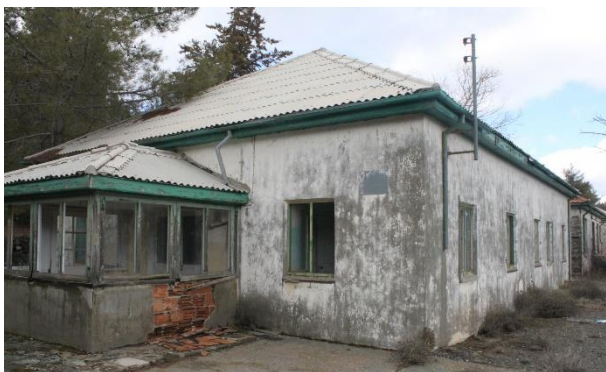
Εικ. 4.67. Άποψη της δυτικής πτέρυγας του νοσοκομείου του Αμιάντου, η οποία κατασκευάστηκε το 1948, 2015 (συλλογή συγγραφέα)
