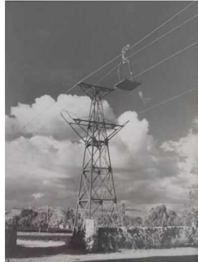
Εικ. 2.49. Μεταλλικός πυλώνας του εναέριου καλωδιωτού μεταφορικού συστήματος του Αμιάντου, άγνωστης χρονολογίας (Αρχείο ΠΕΟ).
