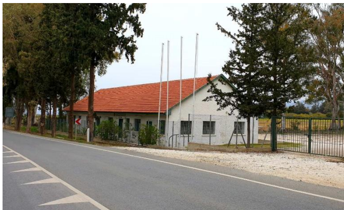
Εικ. 3.25. Το κτήριο του ηλεκτροπαραγωγικού σταθμού και μετέπειτα των γραφείων του μεταλλείου της Λίμνης, 2020 (συλλογή συγγραφέα).
