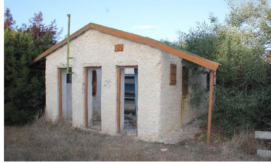
Εικ. 4.25. Τυπικό βοηθητικό κτήριο τουαλετών, πλυσταριών και κοτετσιών που εξυπηρετούσε δύο έως και τέσσερις κατοικίες στον οικισμό Πλατειές της ΕΜΕ, 2015 (συλλογή συγγραφέα).
