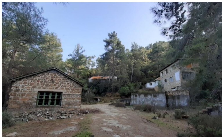
Εικ. 2.39. Άποψη γραφείων, κατοικιών και αποθήκης της περιοχής του εργοστασίου εμπλουτισμού του Αγ. Νικολάου, 2020 (συλλογή συγγραφέα).
