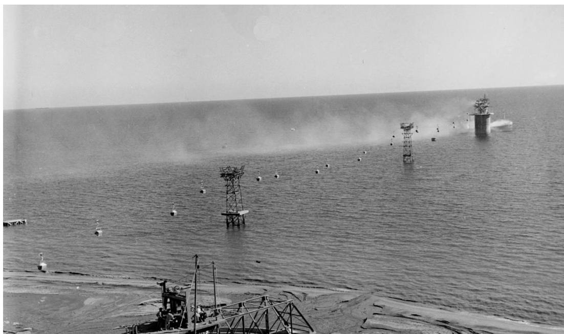
Εικ. 2.52. Άποψη του εναέριου καλωδιωτού μεταφορικού συστήματος της ΑΕΕΧΠΛ στην περιοχή του Βασιλικού, c. 1950s – 1960s (Γραφείο Τύπου και Πληροφοριών).
