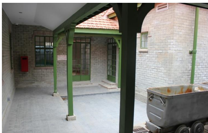
Εικ. 2.88. Το αίθριο του κτηρίου των κεντρικών γραφείων του Αμιάντου, 2017 (συλλογή συγγραφέα).
