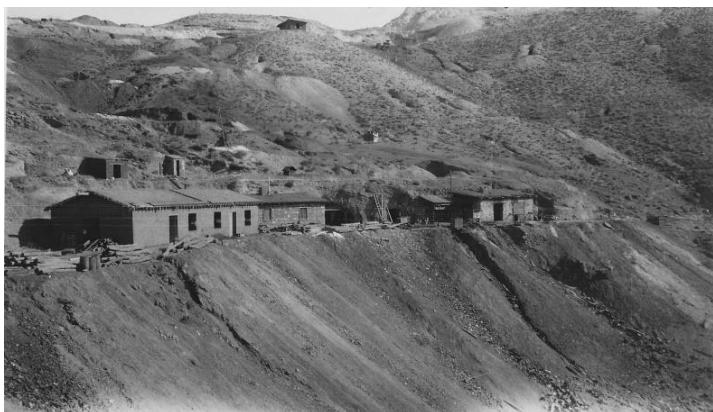
Εικ. 1.22. Άποψη εγκαταστάσεων της CMC στην περιοχή του μεταλλείου ανατολικά της Μονής της Σκουριώπισσας, 1923 (Charles F. και Ruby L. Jackson, συλλογή William J. Everett).
