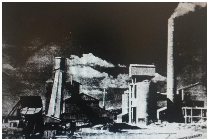
4.10. Άποψη του Τσιμεντοποιείου της Μονής, 1957 (Cyprus pictorial, 12 th July 1957, Γραφείο Τύπου και Πληροφοριών).
