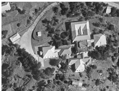
Εικ. 4.66. Το νοσοκομείο του Αμιάντου μετά τις προσθήκες του 1948 όπως αποτυπώθηκε σε αεροφωτογραφία του 1963 (Τμ. Κτηματολογίου και Χωρομετρίας).
