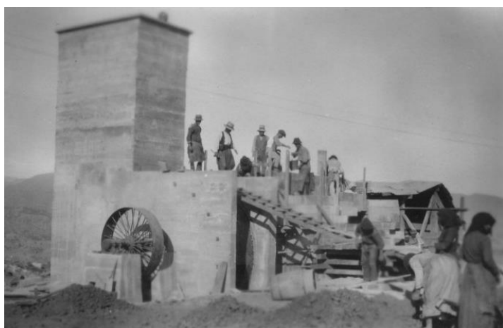
Εικ. 2.56. Εργασίες για την κατασκευή εγκατάστασης φρεατίου από οπλισμένο σκυρόδεμα στην Σκουριώτισσα, c. 1923-1925 (Charles F. και Ruby L. Jackson, συλλογή William J. Everett).
