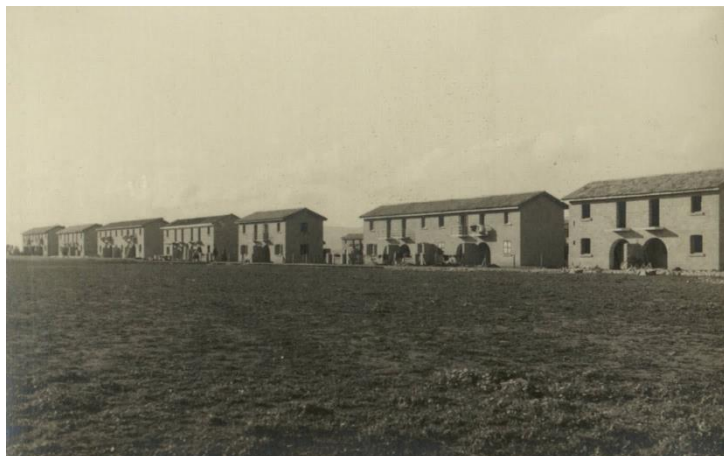
Εικ. 4.51. Άποψη των εργατικών κατοικιών που κατασκεύασε η κυβέρνηση το 1946 στην περιοχή Ομορφίτα της Λευκωσίας, αμέσως μετά την ολοκλήρωση της ανέγερσής τους (Κρατικό Αρχείο, SA1 849/44/2N).
