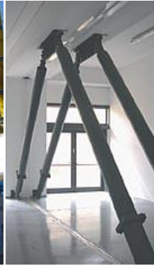
Σχήμα 2.2 – Σύνδεσμοι δυσκαμψίας ανθεκτικοί σε λυγισμό σε κατασκευή προκατασκευασμένου ο.σ. στην Ανκόνα (Ιταλία) - (πηγή: FIPMEC srl)
