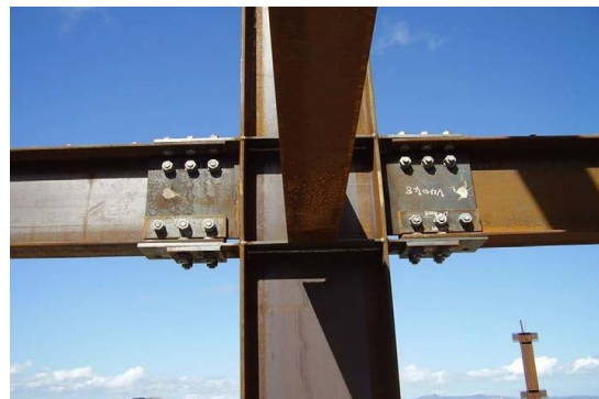
Σχήμα 2.7 : Αρθρωτός κόμβος ολίσθησης με ασύμμετρους αποσβεστήρες τριβής του βραβευμένου χωριού Te Puni Village στο Ουέλινγκτον - [13]
