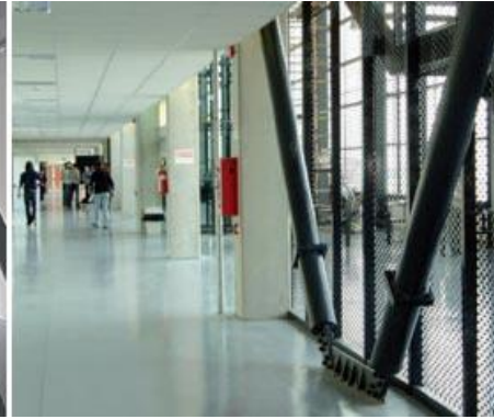
Σχήμα 2.2 – Σύνδεσμοι δυσκαμψίας ανθεκτικοί σε λυγισμό σε κατασκευή προκατασκευασμένου ο.σ. στην Ανκόνα (Ιταλία) - (πηγή: FIPMEC srl)
