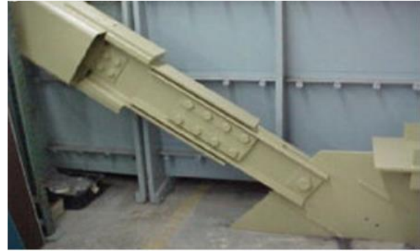
Σχήμα 2.4 : Συσκευές Pall εγκατεστημένες σε ένα μονό διαγώνιο σύνδεσμο στο Εργοστάσιο Εμπορικών Αεροσκαφών Boeing στο Έβερετ, ΗΠΑ - (πηγή: Dr Pall)
