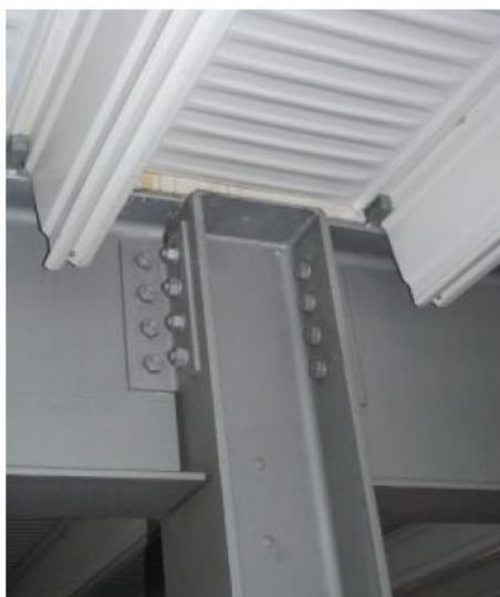
Εικόνα 14: Αρθρωτή σύνδεση δοκού υποστυλώματος
