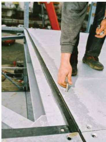
Εικόνα 11: Τοποθέτηση μεταλλικής πλάκας καταστρώματος
