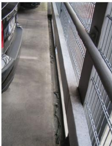
Εικόνα 7: Εξωτερική τοποθέτηση ορθοστατών
