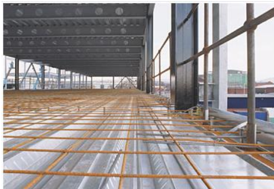
Εικόνα 13: Τοποθέτηση οπλισμού στην άνω παρειά για τον έλεγχο της ρηγμάτωσης
