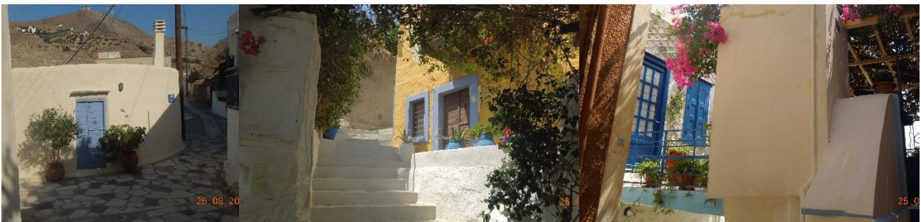
Εικόνα 5.126. Φαλτσογωνία σε κτήριο για την διευκόλυνση της πρόσβασης Πηγή: Ι. Στεφάνου
