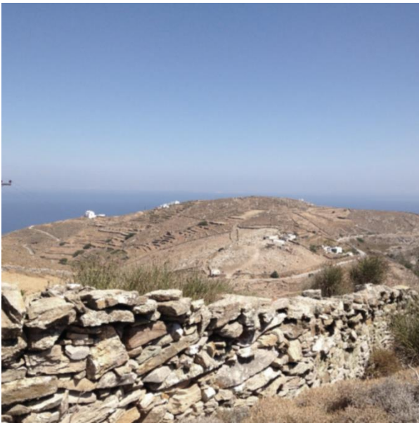
Εικόνα 5.106. Οι ξερολιθιές που καθορίζουν τις ιδιοκτησίες και την απορροή των υδάτων Πηγή: Προσωπικό αρχείο
