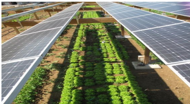
Εικόνα 10: Αγροφωτοβολταϊκό σύστημα. Πηγή: iconsolar.com [56]
