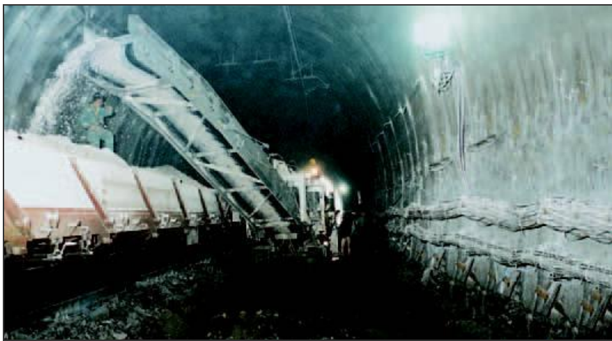
Σχήμα 6.3. Όρυξη στο πάτωμα ενός υπόγειου έργου.
