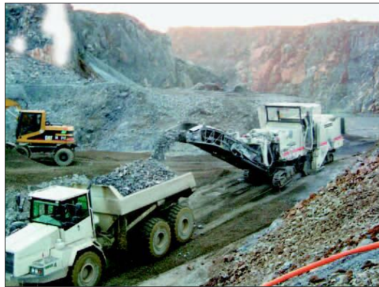
Σχήμα 6.7. Φόρτωση του εξορυγμένου υλικού μπροστά από το μηχάνημα κοπής.
