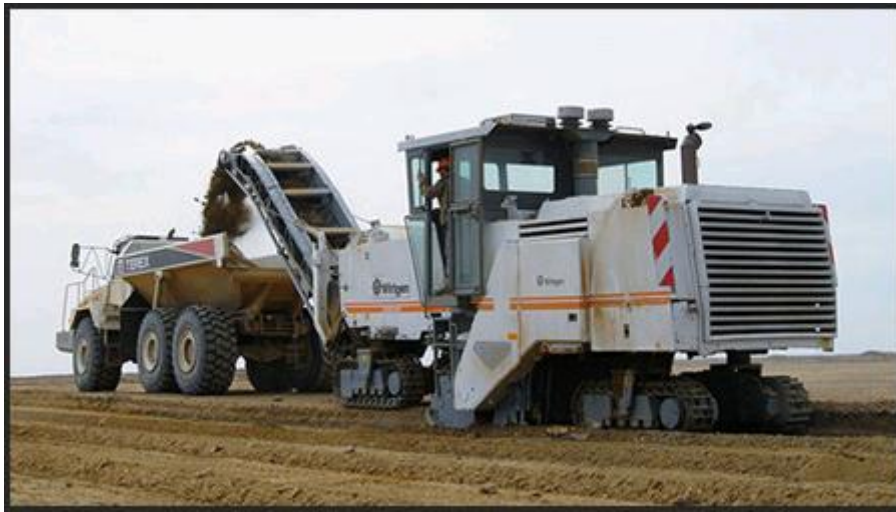
Σχήμα 6.6. Το Surface Miner κατά τη διάρκεια της εξόρυξης.
