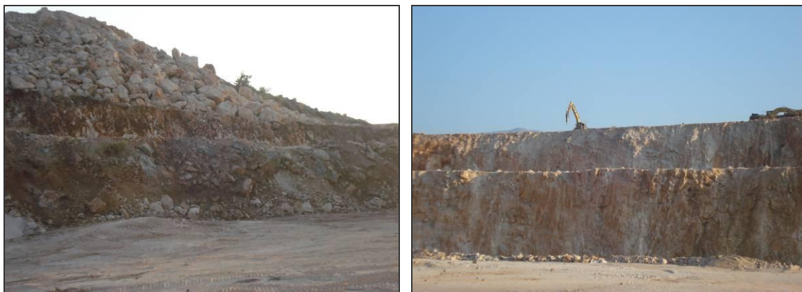
Σχήμα 3.4. α) Εξορυγμένο υλικό με τη χρήση εκρηκτικών β) Διαμόρφωση βαθμίδων λατομείου
