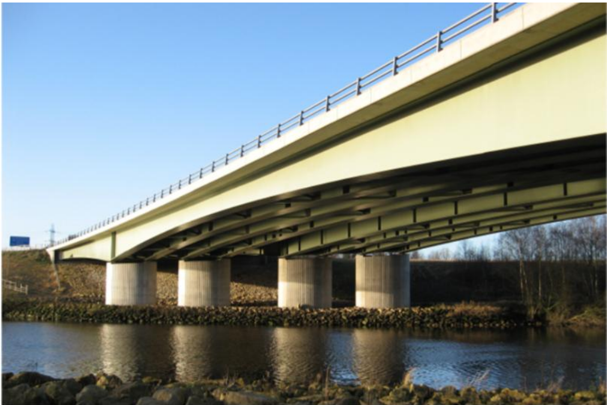
Σχήμα 1.3-Γέφυρα Πολλαπλών Δοκών
