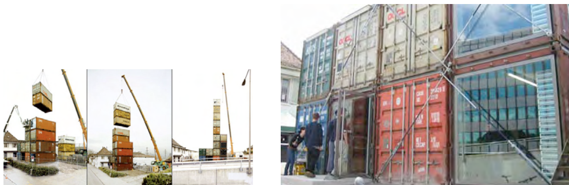
Εικ. 17,18, «Τοποθέτηση των κοντέινερ και είσοδος των Freitag», Ζυρίχη
