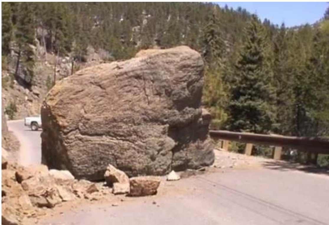
Εικόνα 2.3: Χαρακτηριστικό παράδειγμα καταπτώσεων (Colorandogeologicalsurvey.org)
