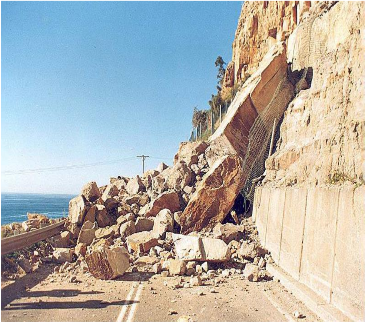
Εικόνα 2.12 : Χαρακτηριστικό παράδειγμα σύνθετων μετακινήσεων ( eiw.now.edu.an )
