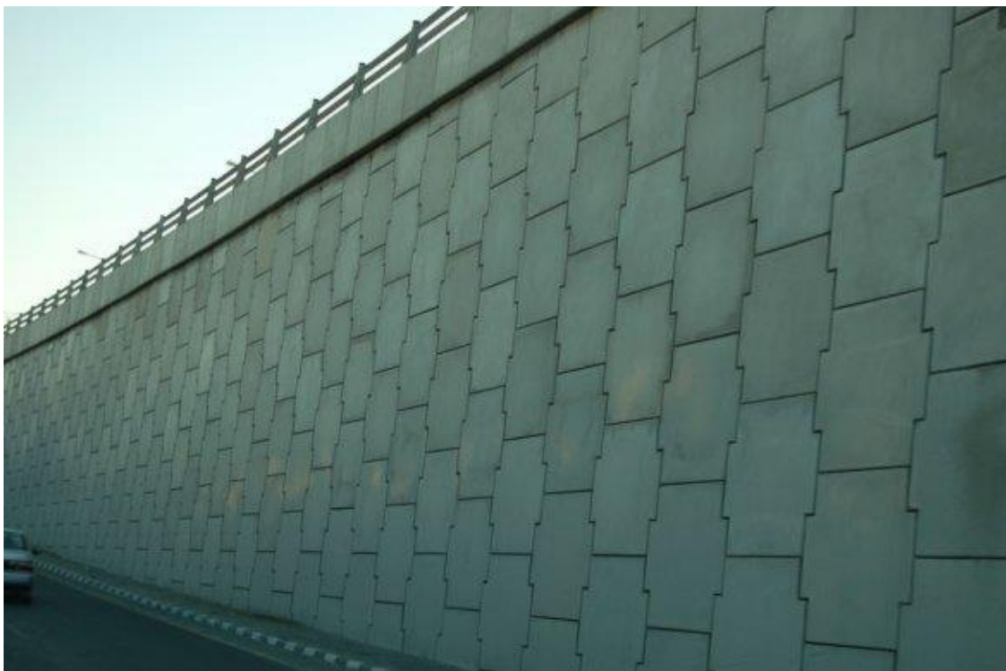
Εικόνα 6.14 : Χαρακτηριστικό παράδειγμα τοίχου οπλισμένης γης (associateseng.com)
