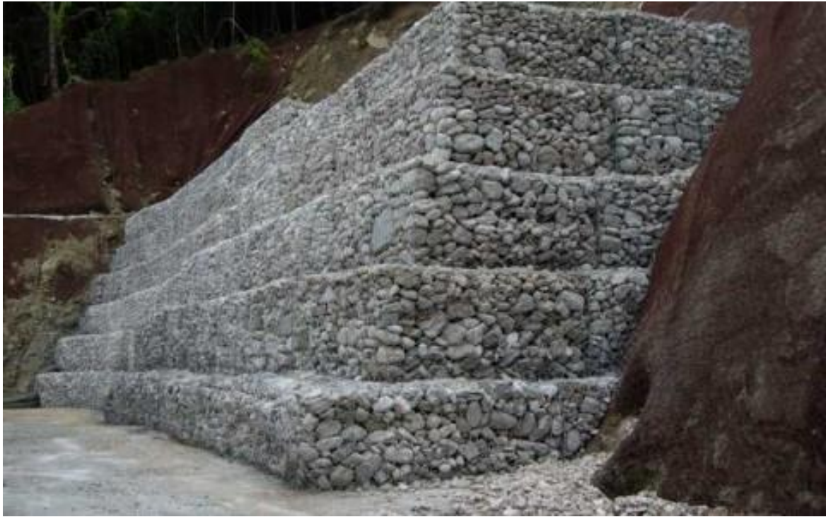
Εικόνα 6.13 : Χαρακτηριστικό παράδειγμα τοίχου από συρματοκιβώτια (qsv.gr)
