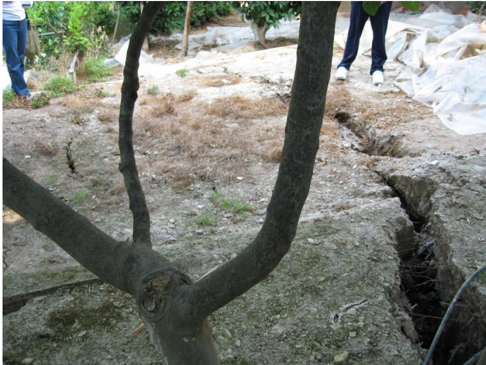
Εικόνα 4.8 : Ρωγμή στην αυλή της κατοικίας μετά τη δεύτερη αστοχία
