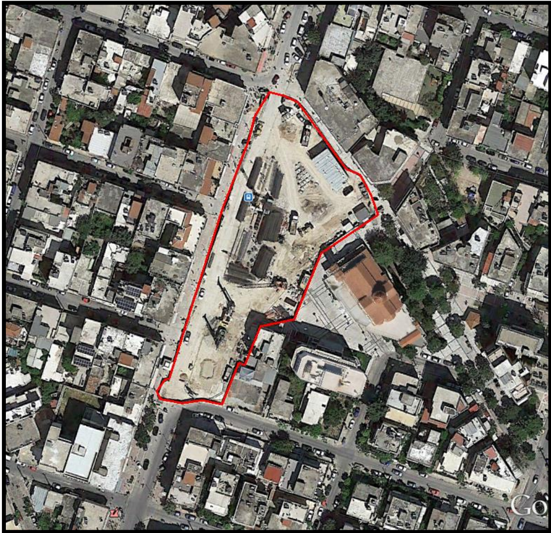
Εικόνα 4.2 Τελικό στάδιο περίφραξης εργοταξίου για την έκβαση εργασιών εκσκαφής - κατασκευής, 13/04/2013 (πηγή: πρόγραμμα Google earth).
