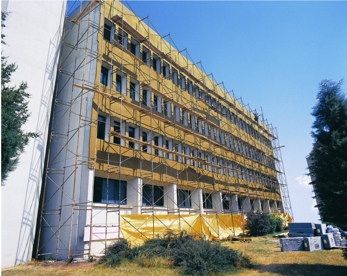
Εικόνα 5.12. Εφαρμογή συστήματος εξωτερικής θερμομόνωσης σε υφιστάμενο κτίριο.
