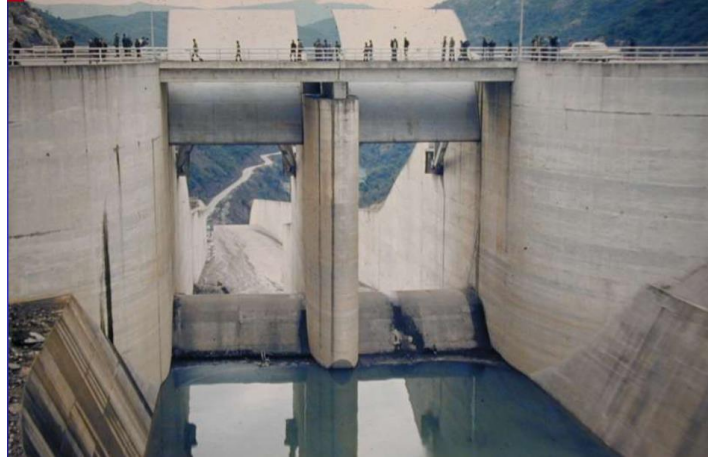
Εικόνα 3.6-5: Τοξωτά θυροφράγματα (Μουτάφης)
